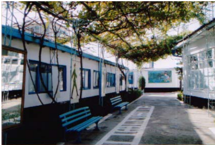
タジキスタン コロニー第7号の管理棟
