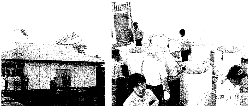
ブンクル州のオニテナガエビ種苗生産施設 (整備中)
