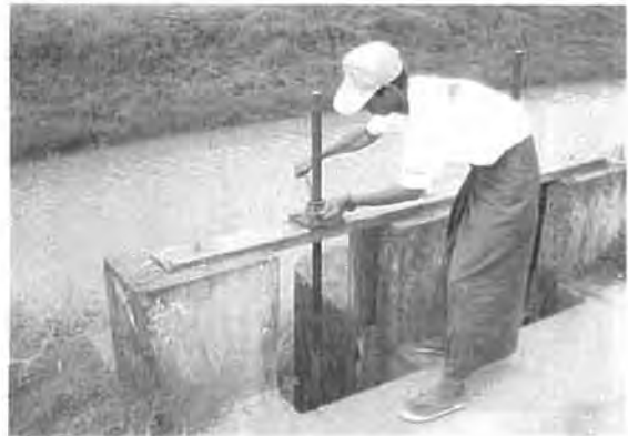
現地調査② 幹線水路から支線水路へ取水するゲートの操作 (それぞれのゲートにゲートキーパーが配置されている)
