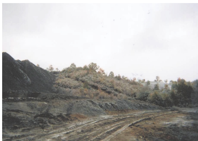
写真 - 10 Coranda鉱山の廃さいダムかん止堤底部（稼動中）
