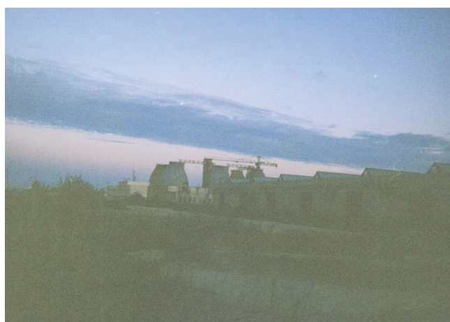
写真 - 18 ブカレスト市(東側)の下水処理場 (建設途中で放棄)
