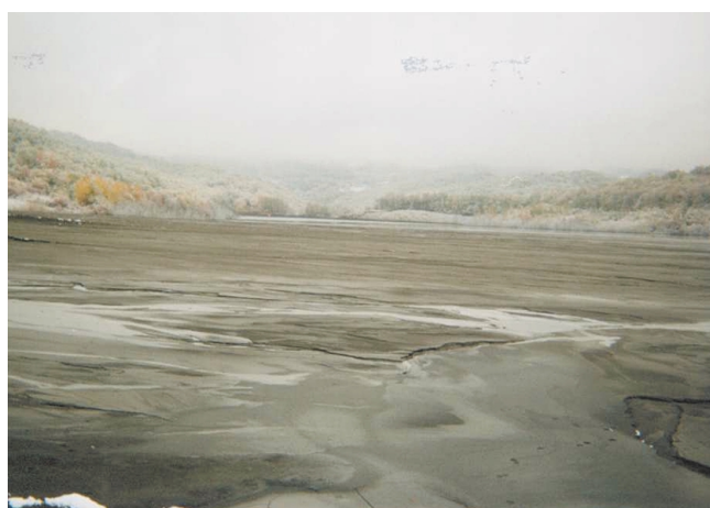
写真 - 12 Coranda鉱山の廃さいダム：場内水はpH11～12
