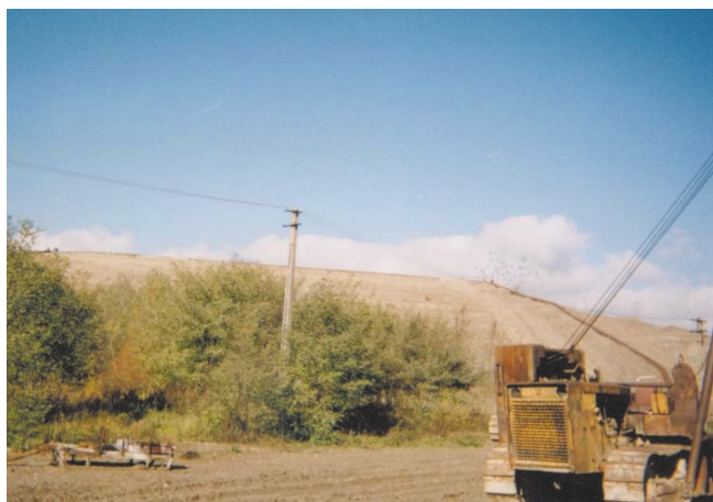
写真 - 13 Brad鉱山の廃さいダムかん止堤 (稼動中)
