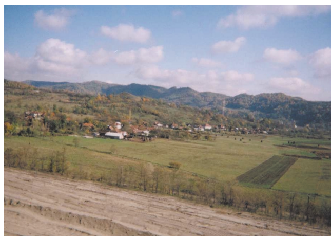
写真 - 16 Brad鉱山の廃さいダム東側下流部 (ダム底部で植生工)
