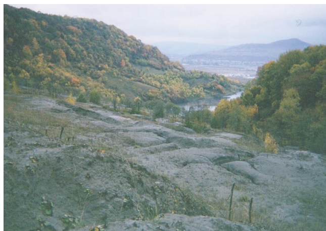
写真 - 8 Certej鉱山廃さいダム下流側法面（法面はガリー状侵食）
