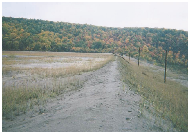
写真 - 7 Certej鉱山廃さいダム：谷型ダムで表流水のオーバー・フロー事故あり
