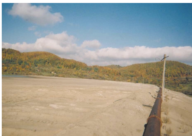
写真 - 15 Brad鉱山の廃さいダムかん止堤頂部
