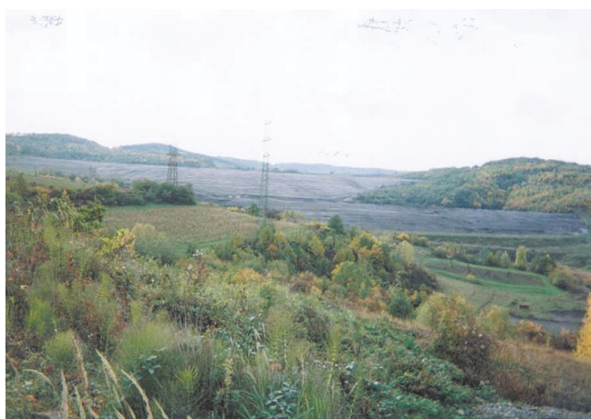
写真 - 9 SMPR Teliuc鉄鉱山の廃さいダム：堆積終了であるが植生がなく廃さいが飛散
