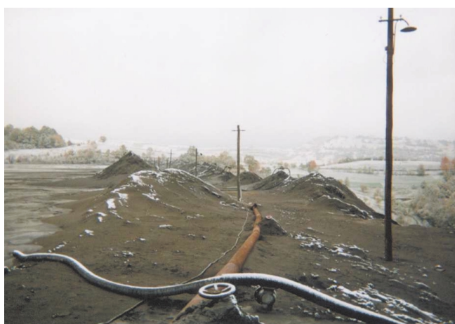
写真 - 11 Coranda鉱山の廃さいダムかん止堤部（外盛式）
