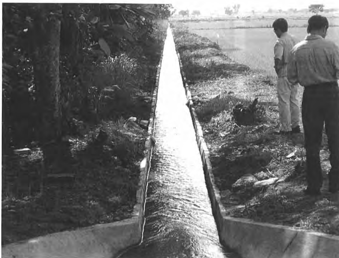
U字溝で整備した小用水路
