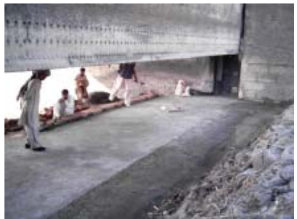
12 Gate クレスト部補修状況
