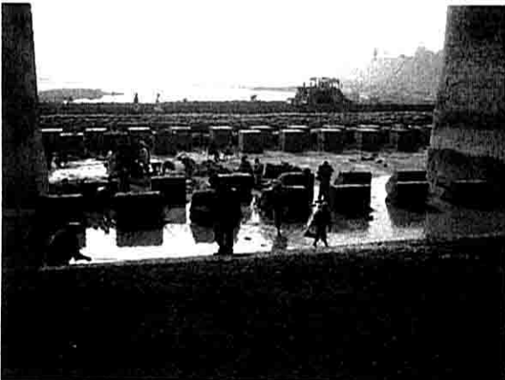
被害箇所スポット測量
