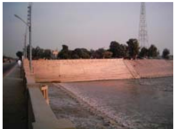
6 Left Bank 下流(土砂吐)
