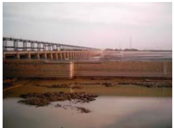
24 Right Bank 下流部
