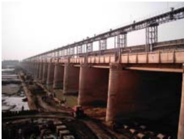
3 Gate 下流(洪水吐)
