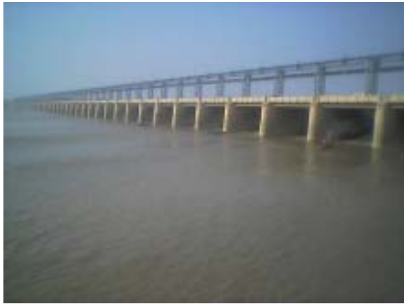
25 Gate 下流の流下状況(1月21日)
