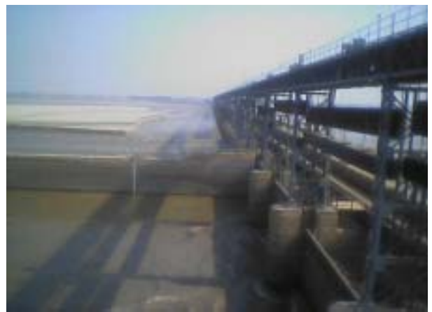
28 Right Bank 上流の流下状況
