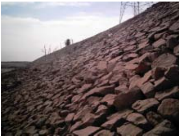
21 Right Bank 下流の護岸部
