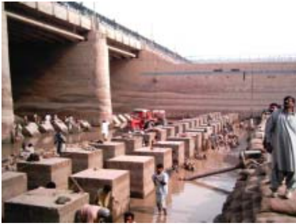
19 土砂吐コンクリートブロックの補修
