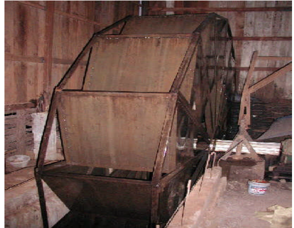
現在稼働中のマイクロ hidro 水車発電所
