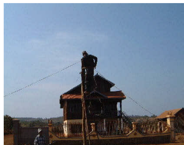
センモノロム市における 配電線工事
