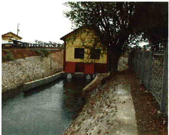
NEDOによるコンボンチャムの小水力発電所（同規模（建屋6m×5m）のものが本件各サイトに建設される）
