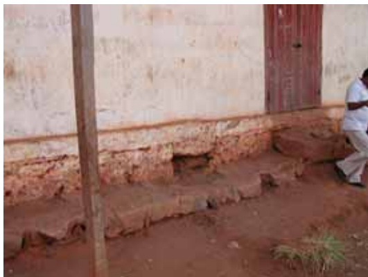
Les fondations se dénudent
