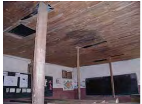
トラスを支えるため、教室の中央に柱を設置している例。
