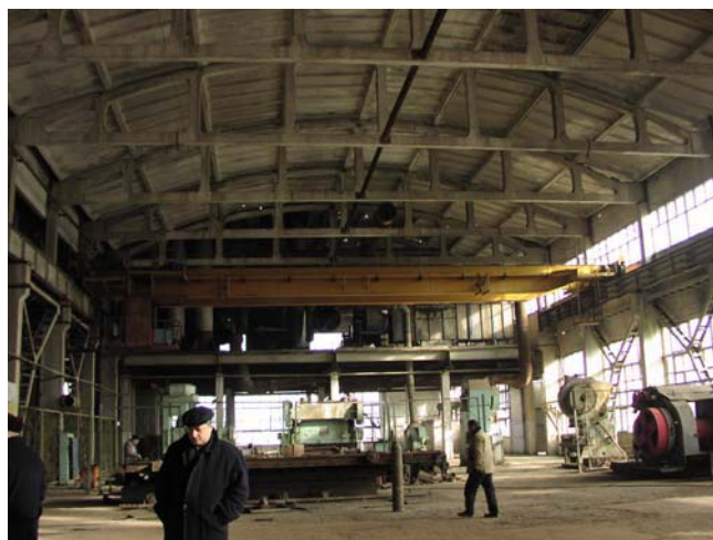
写真：アリバイラムリ機械修理センターの天井走行クレーン
