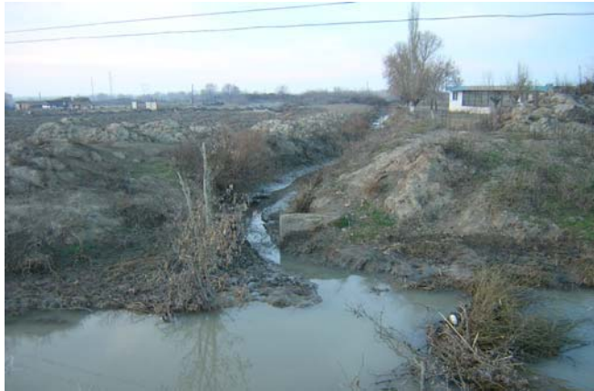
写真： 末端圃場用水路への分水地点付近における土砂の堆積は深刻である（サビラバード地区）
