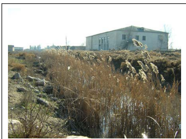
⑤K-1 排水路の堆積土砂状況 (サビラバード地区)
