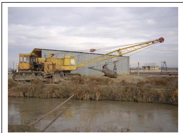
⑮ロシア製掘削機（ドラグライン）及び ロシア製ブルドーザー(手前側) (サートゥリィ地区メインシルヴァン排水路)
