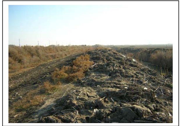
⑧排水路の脇の浚渫後の土砂 (メインシルヴァン排水路)
