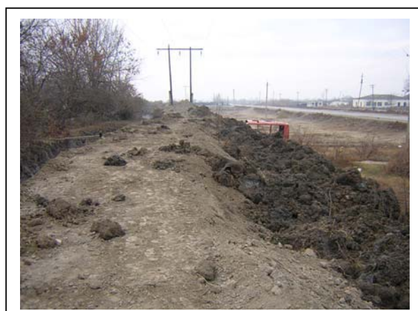
⑥灌漑用水路内の浚渫後の土砂 (サビラバード地区)
