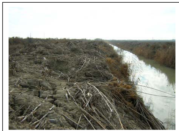
④浚渫後のメインシルヴァン支線排水路
