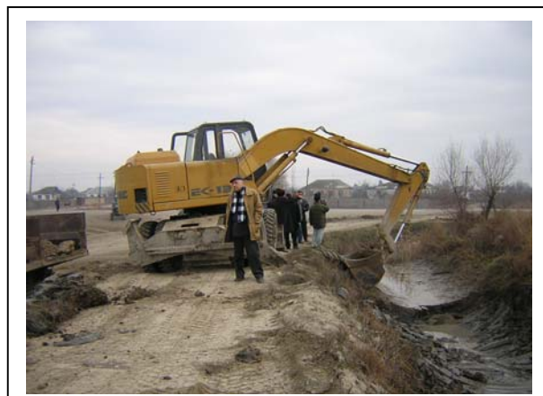
⑯ロシア製掘削機による浚渫作業状況 (サビラバード地区支線排水路)
