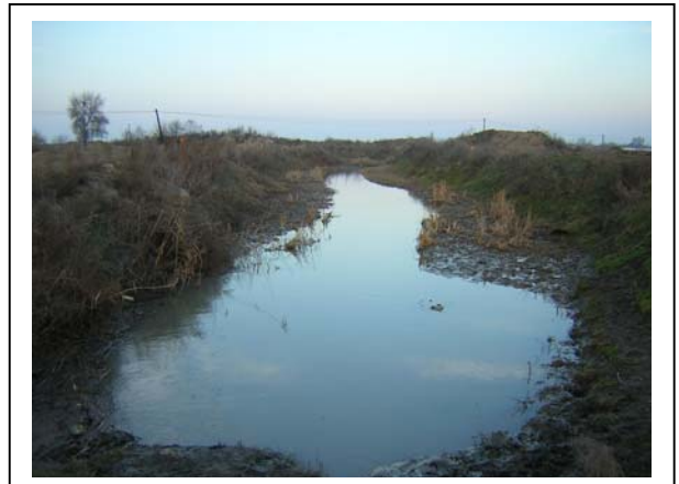
⑩デブール灌漑用水路の堆積土砂状況 (サビラバード地区)
