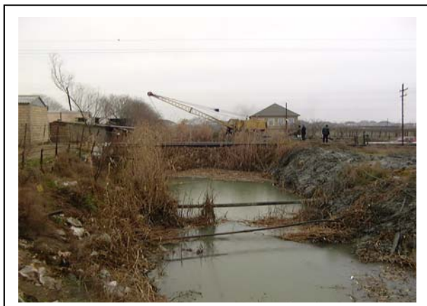
①メインシルヴァン排水路の現況
