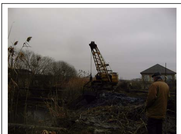
⑰ロシア製掘削機（ドラグライン）による浚渫 作業状況（メインシルヴァン排水路）
