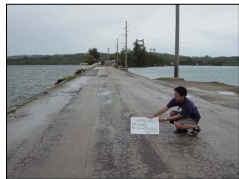
4 KB橋取り付け部。路面には、埋設施設の維持・管理時の掘削跡が多くあり、段差が生じている。
