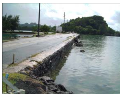
写真:アイライ(西)コースウェイの護岸工現況。扶壁による補強が見られる。
