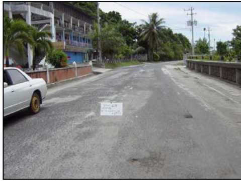
3 道の両側に建物があり狭隘部となっている区間。
