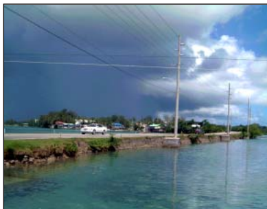
写真:マラカルコースウェイの護岸工現況。比較的損傷が少ない。
