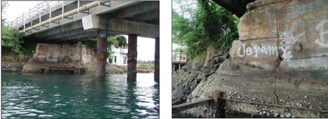
写真 コロール側(A2)橋台前面擁壁現況
