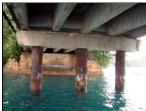
3 パイルベント杭現況。設計図から判断するとH型鋼が構造材で、鋼管及び中詰めコンクリートはH型鋼の保護材である。
