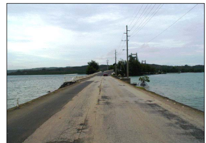
写真:アイライコースウェイ。中ノ島間からKB 橋間の状況。KB 橋取り付け部約 150 m は拡幅改修済みである。
