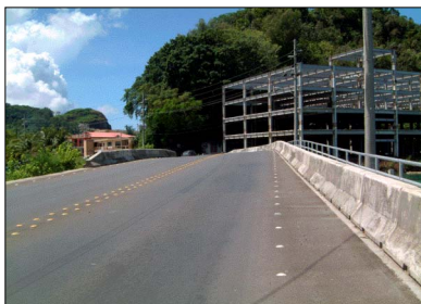
写真:マラカルコースウェイ拡幅改修部。マラカル島方面を望む。
