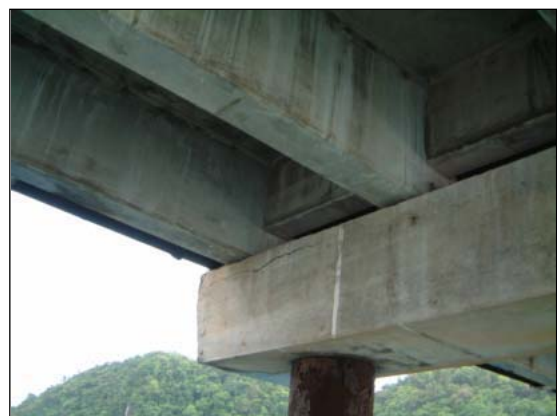
写真 P2 橋脚横梁現況 (コロール側)
