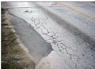
写真:マラカルコースウェイ。ミナト橋近傍での路面詳細。
