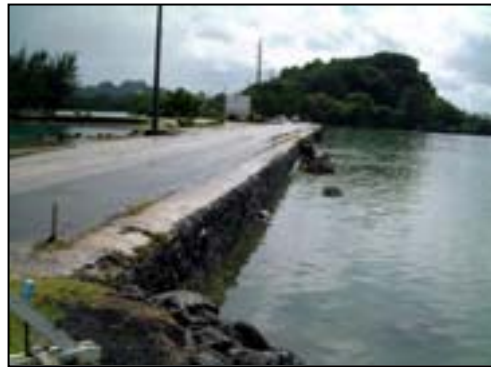
2 護岸工の現況。擁壁による補強が見られる。
