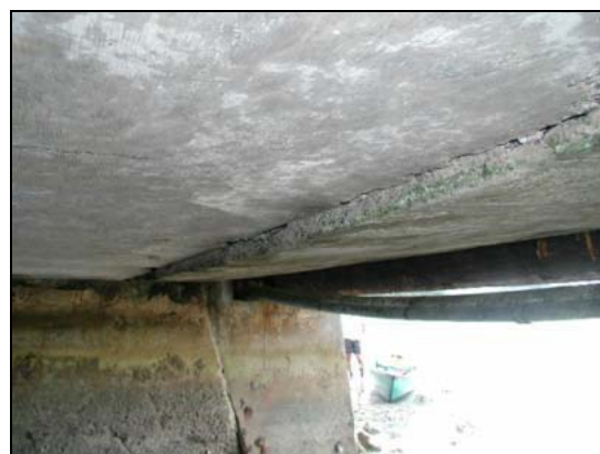
写真 ミュンズ No.1 上床版スラブの一部陥没
