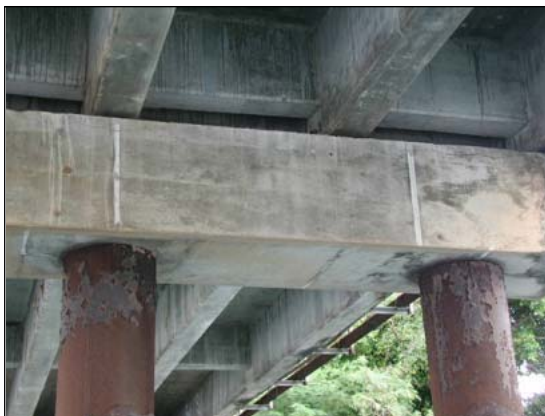
写真 P2 橋脚横梁現況 (マラカル側)
