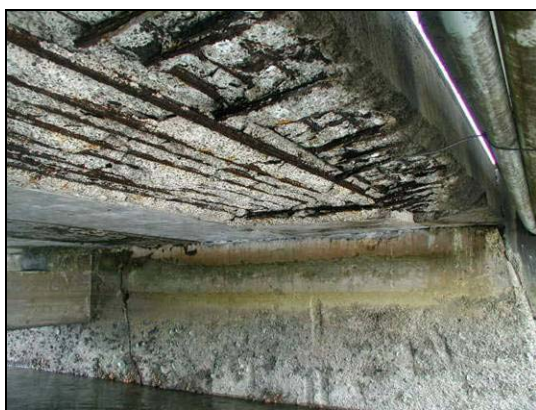
写真 ミュンズ No.2 上床版スラブ下面鉄筋露出・腐食状況
