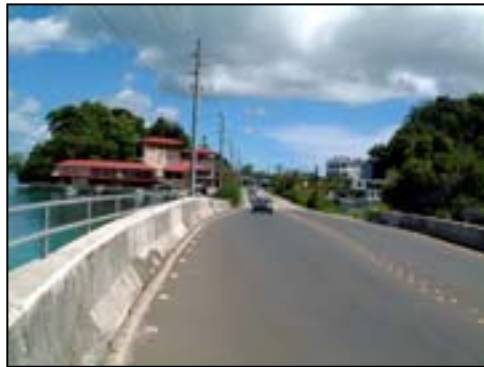
3 マラカル・コースウェイ既改修部にてコロール島側(東方)を望む。両側にジャージー・タイプのバリアが設置され、その外側(北側のみ)に歩道がある。
