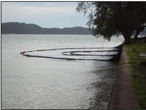
4 2 からの工事排水箇所設置されたシルトフェンス。汚濁防止策を実施している。
