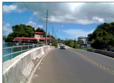
写真:マラカルコースウェイ拡幅改修部。ミナト橋方面を望む。
