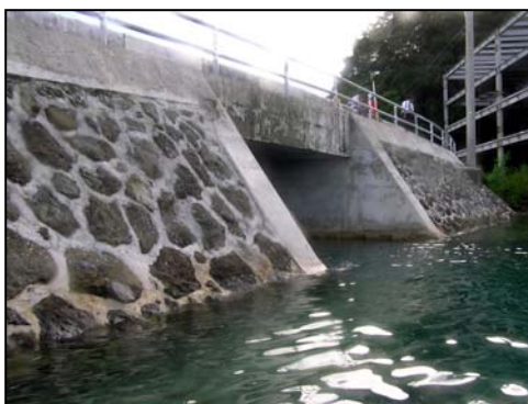
4 既改修部の護岸工及びカルバート現況。護岸の法勾配は、1:0.5程度。
