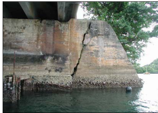
写真 マラカル側(A1)橋台前面擁壁亀裂現況
