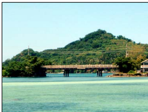
1 ミナト橋全景。1979年に架け替えられたプレキャストPCT桁橋。橋長約63m(3@21m)
