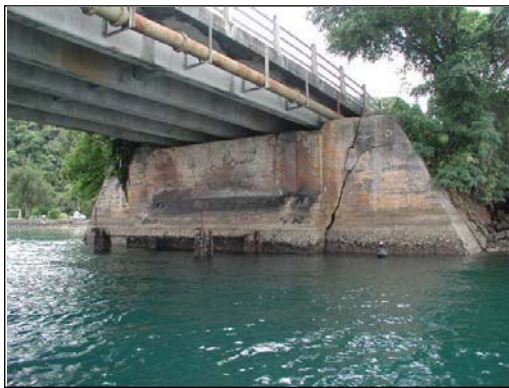
写真 マラカル側(A1)橋台前面擁壁亀裂現況
