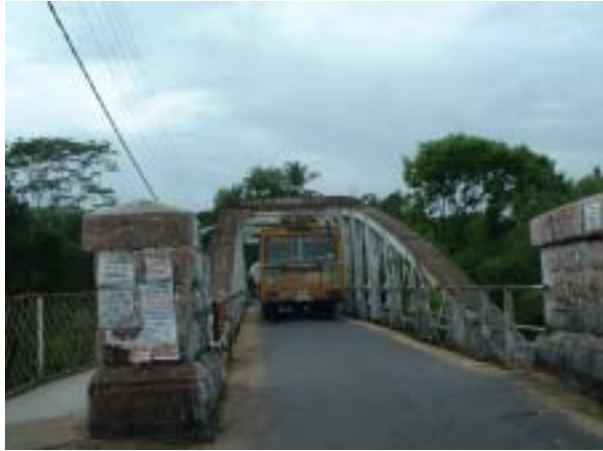
幅員 (3.6m) と建築限界 (4.0m) が不足し、大型車の通行は余裕がない。コンテナ車は高さ制限のため通行できない。
