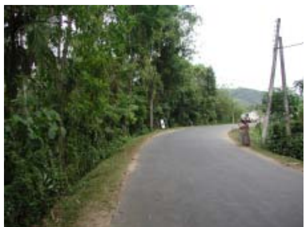
右岸取り付け道路から橋方向を見る。沿道に家屋はない。架橋計画ルートは写真の向かって左を進む。
