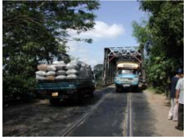
交互通行。橋梁幅員(4.85m)が狭いので右岸で待機するトラックと通過するバス
