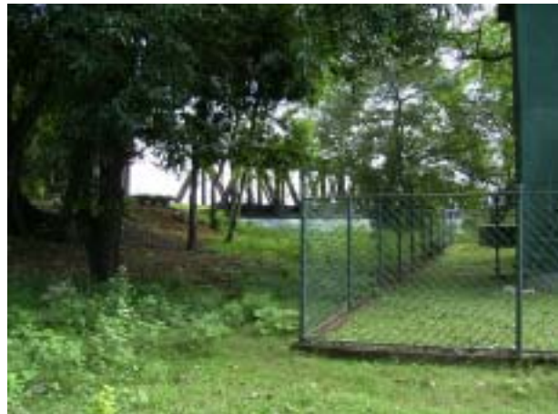
左岸取り付け道路盛土部の状況。写真の向かって右のフェンス内はポンプ施設
