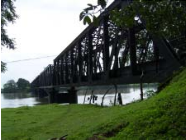
マナンピティヤ橋全景、左岸下流より
