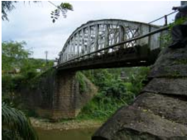
ルワンウェラ橋全景、右岸上流より
