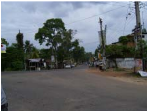
右岸交差点から北側の取り付け道路を見る。橋は写真の向かって左。沿道は家屋・商店が建ち並ぶ。
