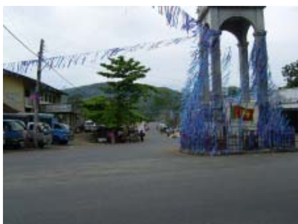
ルワンウェラの町。左岸取り付け道路（国道 B-445）方向を国道 AA-021 の交差点から見る。
