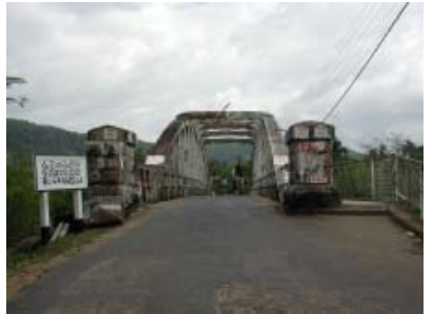
橋梁正面、右岸より
