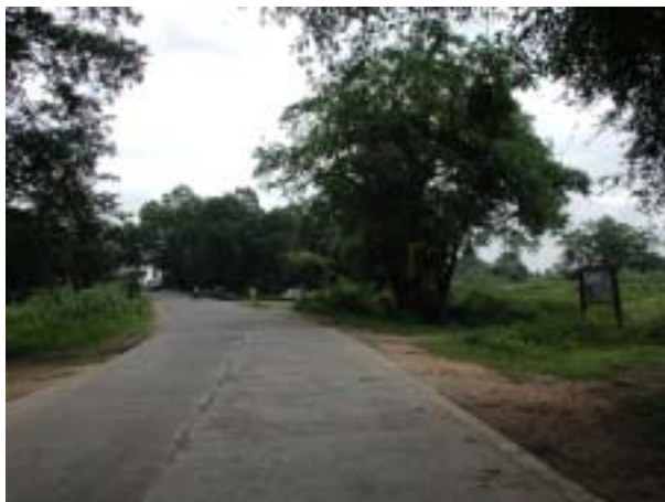
左岸取り付け道路から橋方向を見る。写真の向かって右側が架橋計画方向
