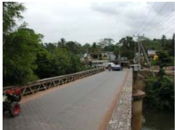
橋梁正面、左岸より
