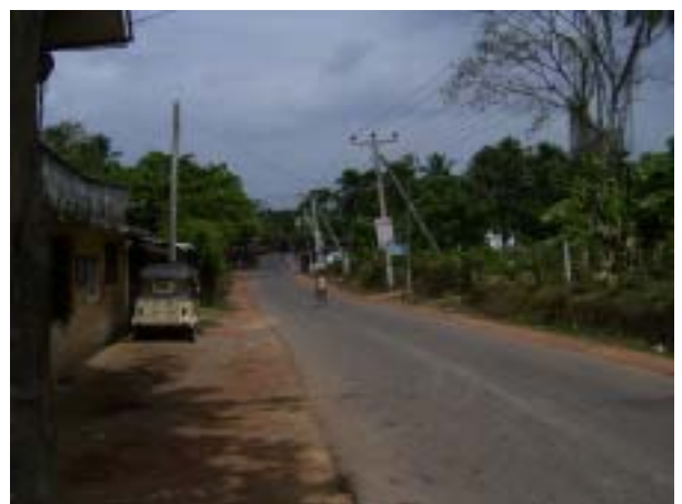
右岸南側の取り付け道路から北方向に交差点を見る。川側（写真の向かって左）の沿道は家屋が並び、反対側（向かって右）は墓地
