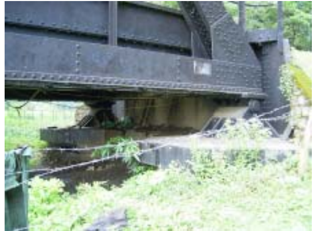
左岸橋台の支承付近。よく維持管理されており錆、泥の堆積、沈下は見られない。
