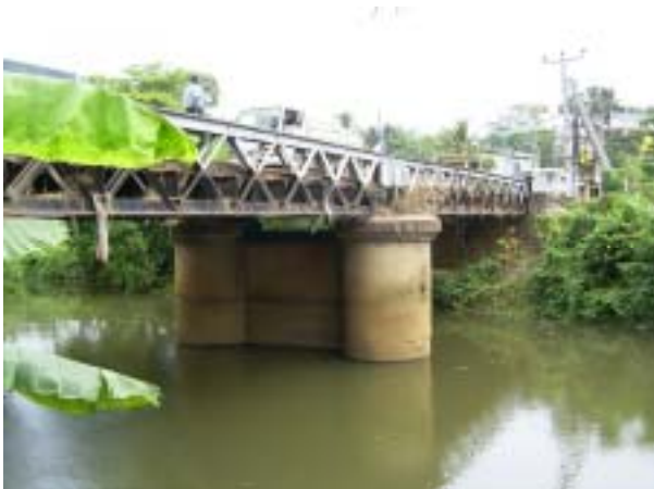
コトゥゴダ橋全景、左岸上流より
