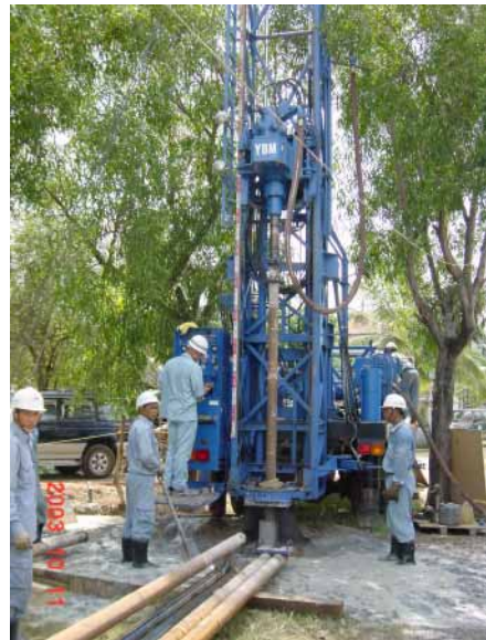
JICA の「プノンペン市周辺村落給水計画」での井戸掘削作業
