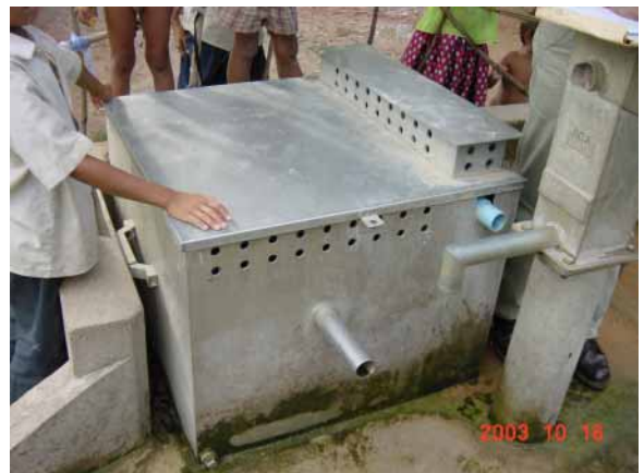
JICA 開発調査試験施工で設置された除鉄装置
