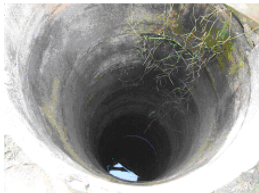
コンクリート巻き浅井戸の内部
