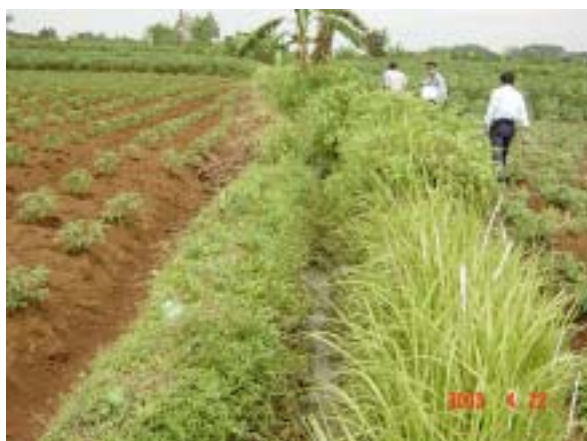
サイト北西角より西側境界沿いにある排水路を見る
