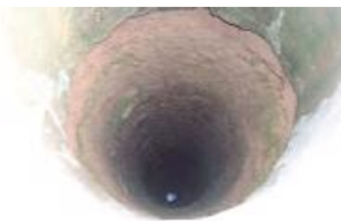
《伝統井戸の内部、素堀で孔壁は保護されていない》
