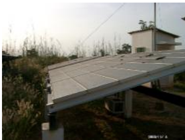
上：制御機器、下：ソーラーパネル (共に日本施工施設)
