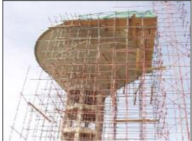
施工中の給水塔（地方都市用、中国系企業受注）
