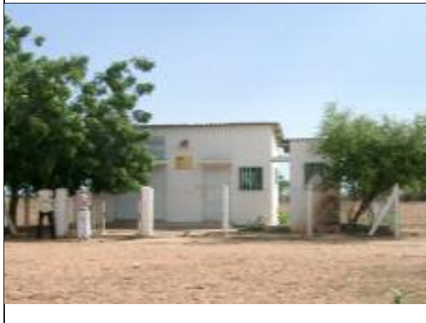
日本施工の給水施設、発電機室
