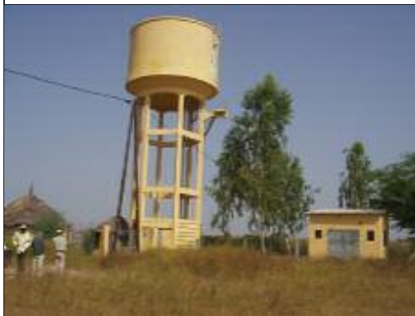
ベルギーの建設した給水施設（給水塔と発電機室）
