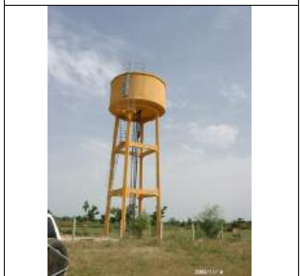
CEAO プロジェクトで建設した給水施設（給水塔）
