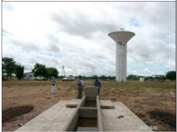
日本施工の給水施設、家畜水飲み場と給水塔 (150m 3 )
