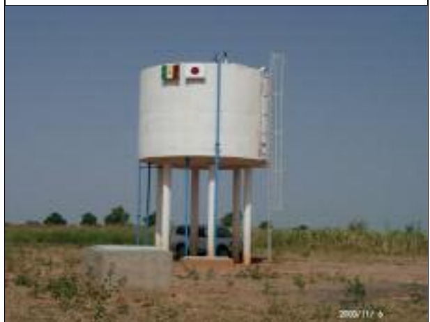
日本施工のソーラーシステム用給水塔 (50m 3 )
