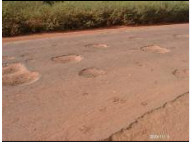
タンバクンダ - カオラック間、タンバクンダの東側は舗装が荒れている。
