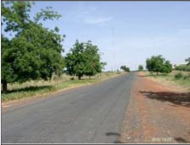
主要国道（ルガ - リンゲール間） 舗装状態は良好。
