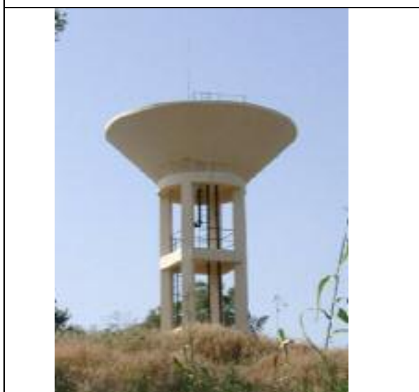
ドイツ（GTZ）の建設した給水施設（給水塔）
