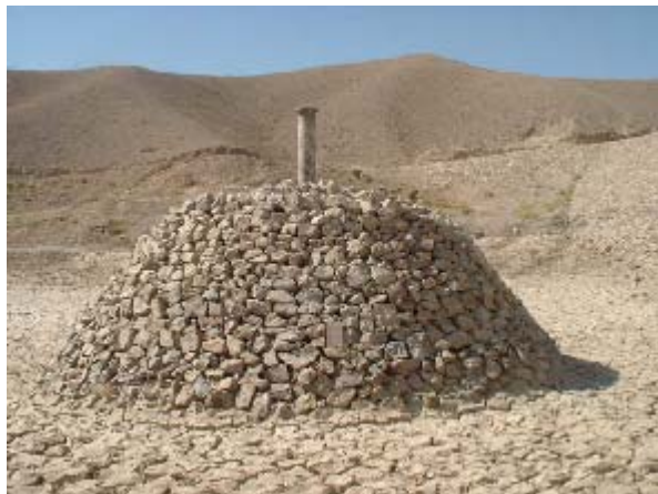
取水塔の上部の石積みが、悪戯で取り除かれている
