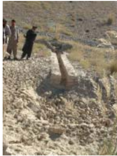
同左 涵養ピット シルトが堆積している ⑩
