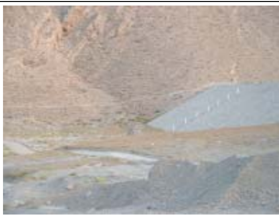
ダム上流側にみられる取水塔と水位測定ポール Dara DAD
