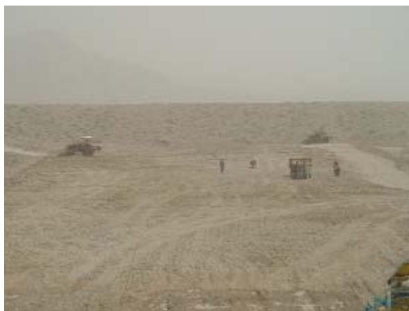
同左工事現場全体風景 少ない機材で施工している
