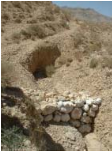
Leaky Dam 上流の小規模チェックダム ⑦
