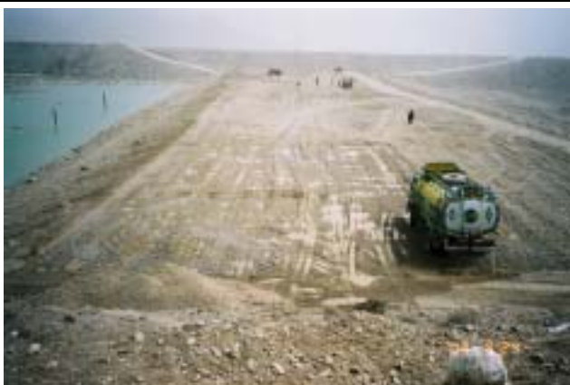
Dashtak DAD 堤体盛土中。散水車による散水および排土板付トラクターによる敷均し作業が行われている ③⑧
