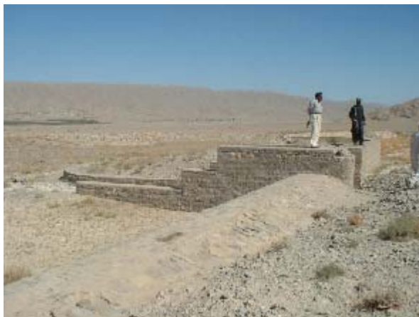
地下水涵養プロジェクト 洪水取水施設
