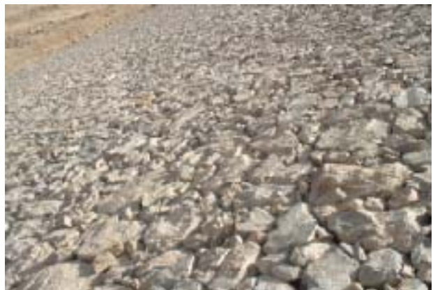
Murghai Kotal DAD の上流面 丁寧な施工のリップラップ ③
