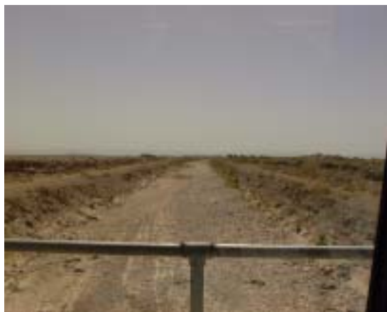
Toiwar FIS 幹線用水路(河川の右岸)、上流側から 下流を望む
