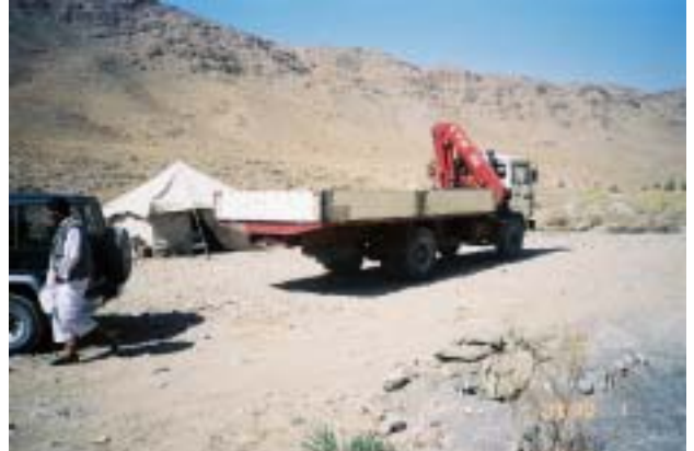
上記井戸掘削現場で待機しているクレーン付トラック
