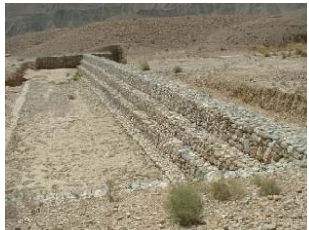
Leaky Dam 下流ダム このダム貯水池でも涵 養を図る ⑦
