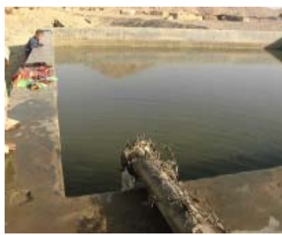
Simali 村圃場の管井(Tube well)からの用水の貯 水槽(Head storage tank) ③⑩
