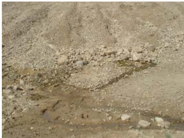
ダム下流法尻からの湧水 (Gatero DAD) ⑪
