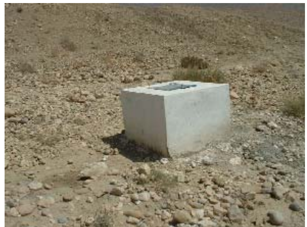
水位観測孔のコンクリート保護 (Leaky Dam)
