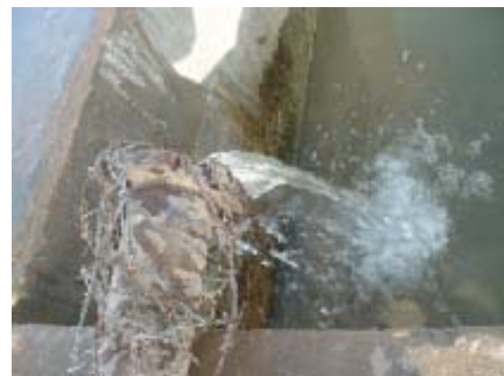
揚水状況 水は一旦タンクに貯留される 雑用水としても使用される 約 1 ㍲/秒 ③
