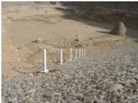
Murghai Kotal DAD にも取水塔と水位観測用ポールが据え付けられている ③
