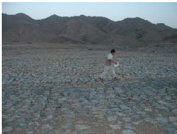
洪水吐は蛇籠で丁寧に保護されている（Torkhezai DAD） ⑥
