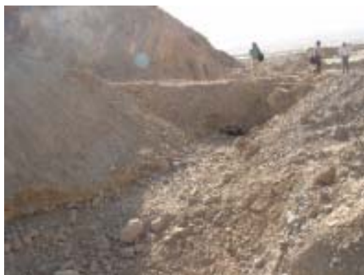
下流放流管から続く水路 アクセス道路に MS パイプが埋設されている Murghai Kotal DAD ③
