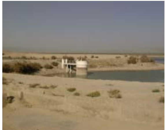
Khusdil Khan Bund Irrigation Scheme 貯水池 取水塔 ㊦
