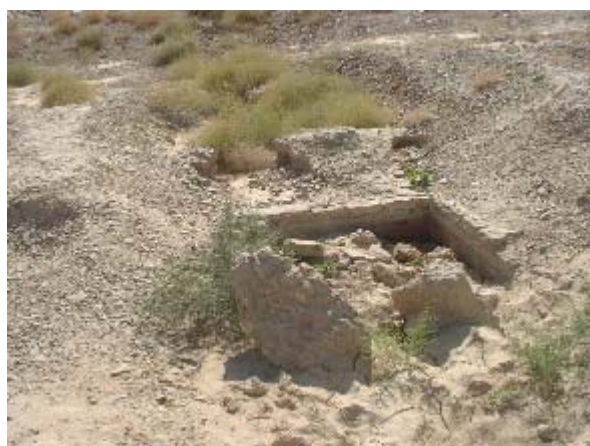
下流放流管はシルトに埋没している（Ghutai Shela DAD） ⑬
