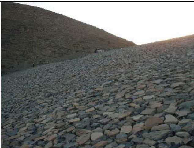
Chinjan DAD の上流面 丁寧な施工のリップラップ ④
