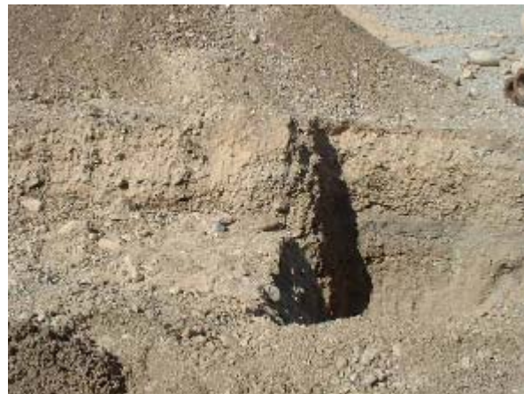
下流放流管用カットオフ用トレンチ (Isplingi DAD)
