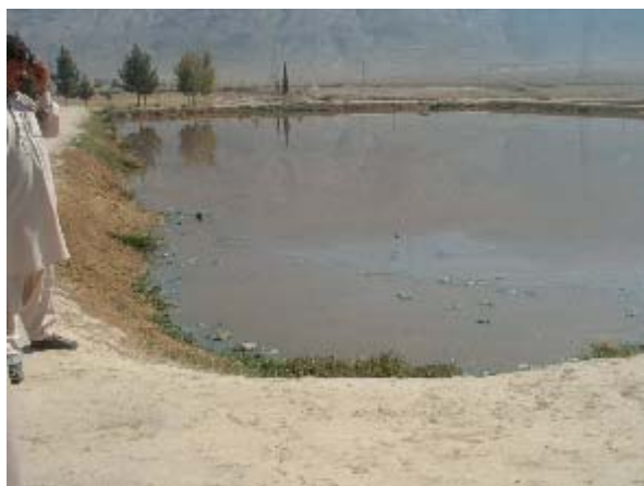
QA-4 と 100m の距離の污水沈殿地
