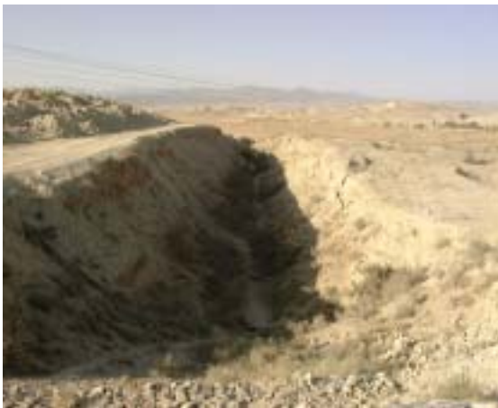
Khusdil Khan Bund Irrigation Scheme 幹線用 水路カルバート部 取水塔から下流を望む ㊦
