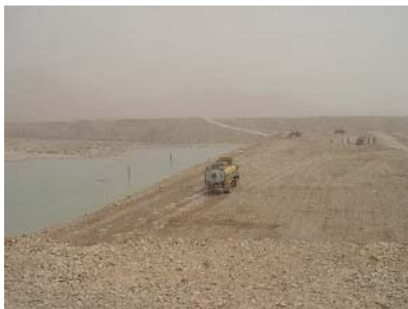
施工中の Dashtak DAD 撒水中
