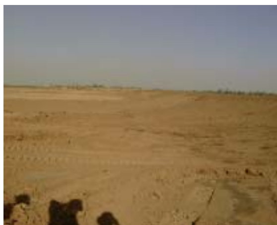
完成した Erri Ganda 右岸上流部から Ganda 上流側法面を望む ㉗
