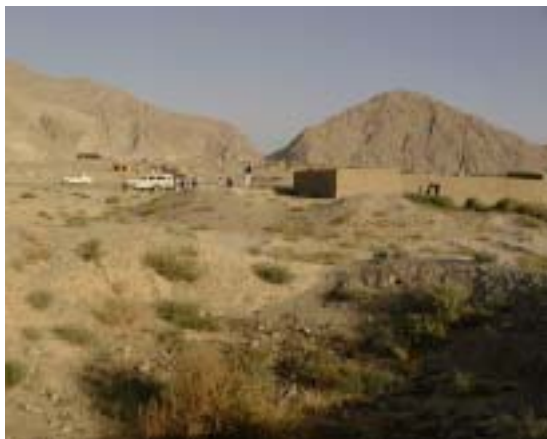
Murghi Kotal DAD 下流の Simali 村から ダム のサイト方向を望む ③⑩
