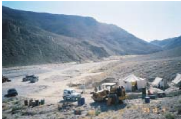
Isplingi DAD 建設現場全景（堤敷のカットオフトレレンチ掘削中、手前は建設業者のキャンプ） ③⑨
