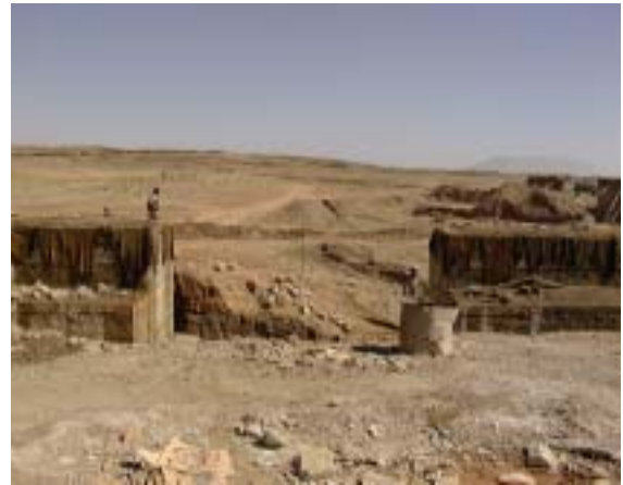
Tora Khula FIS (工事中) 取水工の右岸取水口センターライン 幹線用水路下流側から ㊤
