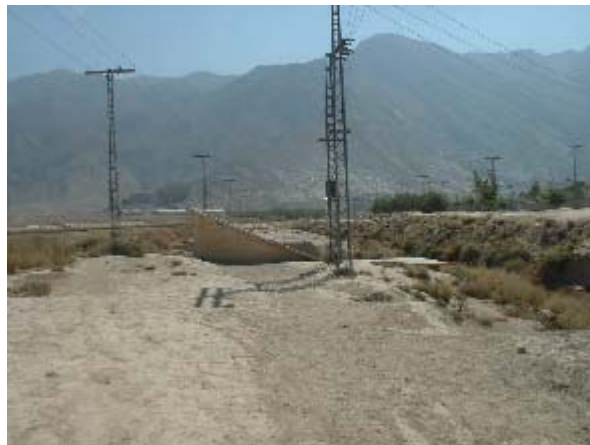
同左季節河川からの取水設備 現在は稼働していない ㉑
