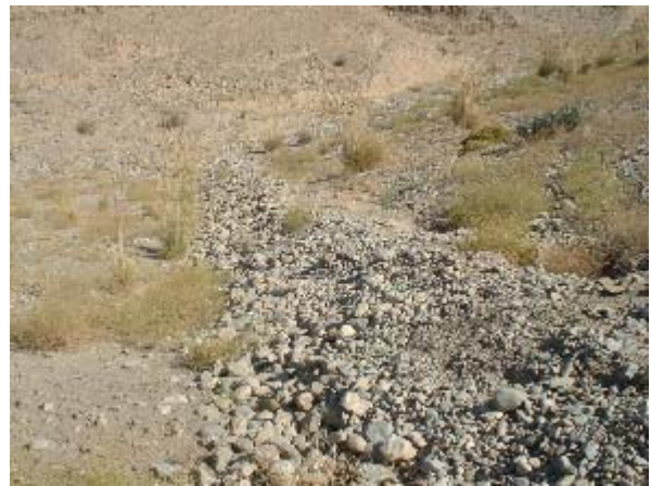
堤体下流法尻のドレーン (Shagai II DAD)
