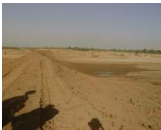
完成した Erri Ganda 右岸端から Ganda 下流 側法面を望む ㉘
