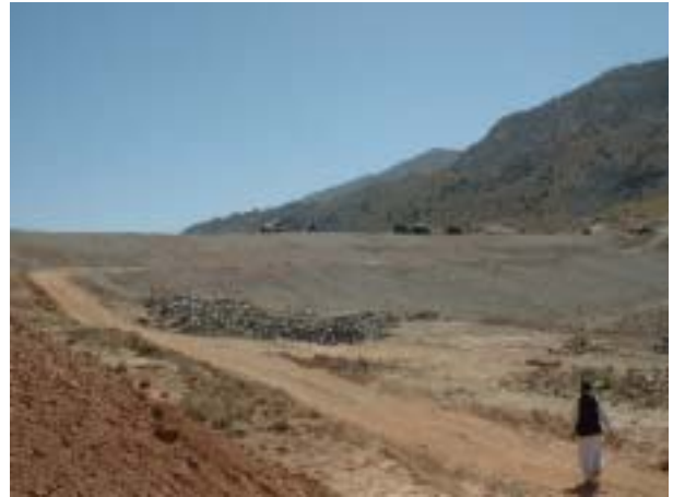
建設中の Spera Ragha DAD.洪水吐建設中
