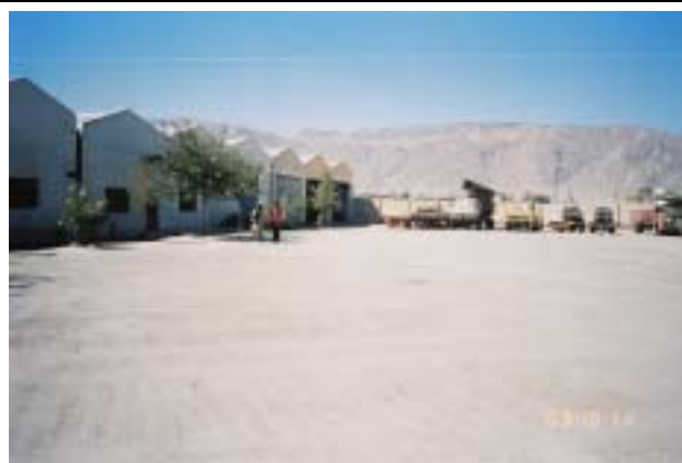
灌漑電力局修理工場の全景
