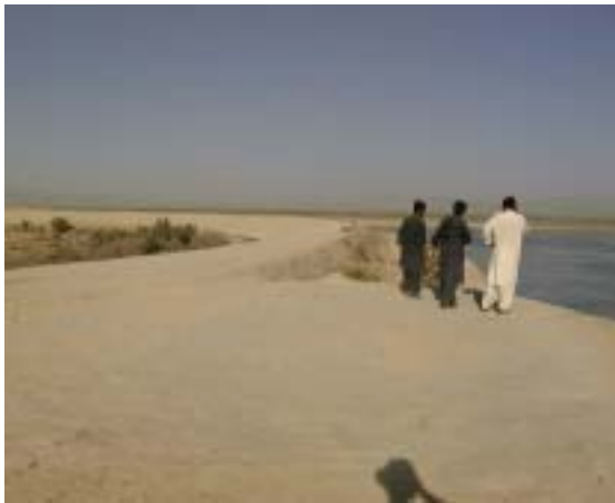
Khusdil Khan Bund Irrigation Scheme 貯水ダ ム堤体 ㊦
