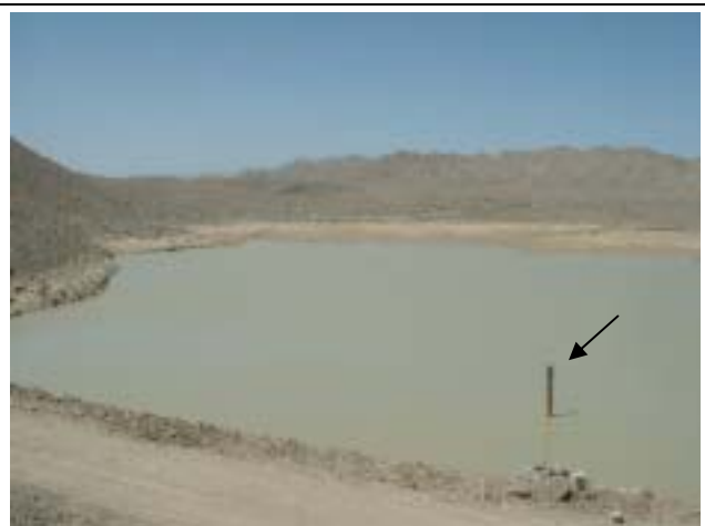
取水塔完成前に洪水到来 保護前の MS パイプが貯水池に見える ④
