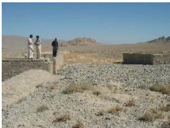
同上 洪水取水トレンクウォール
