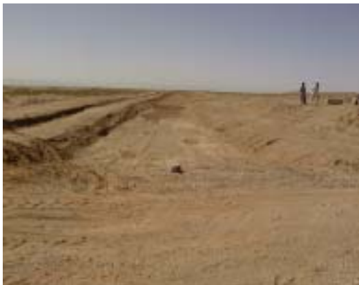
Tora Khula FIS (工事中) 取水工の右岸幹線用水路センターライン 取水口から下流側を望む ㊤
