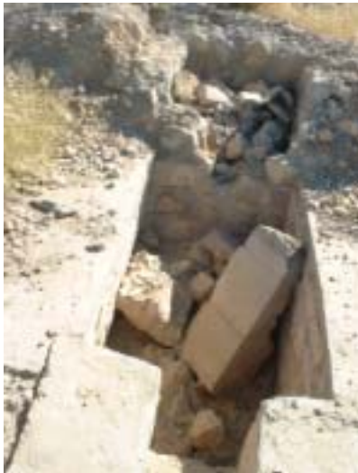
沈砂ピット 適切な清掃がなされていない ⑩
