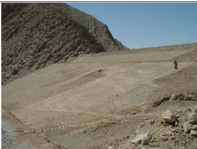
Chinjan DAD の下流面 浸食防止砂利施工前 ④
