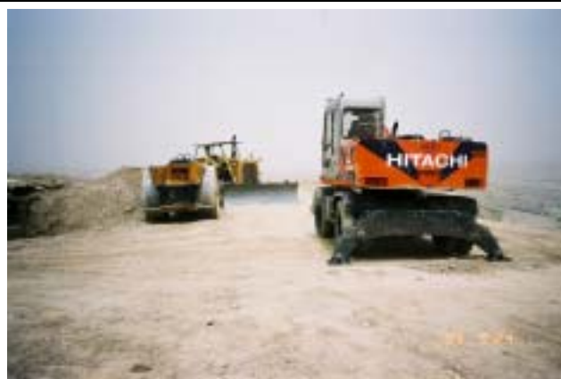
Dashtak DAD 建設現場に待機中のホイール式バックホー、ロードローラ（3 輪マカダムローラ）、ブルドーザ ③⑧
