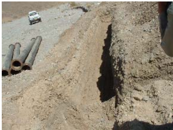
下流放流管の敷設現場 (Isplingi DAD)
