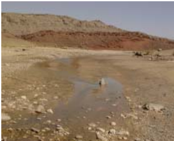
Toiwar Flood Irrigation Scheme (FIS)の取水堰 から河川上流側を望む ㉔
