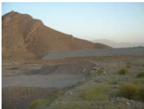
Dara DAD(クエッタ)上流面 最近完成 建設後洪水は発生していない
