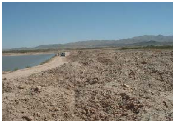
浚渫された Balozai DAD 浚渫土が堤体下流に 投棄されている
