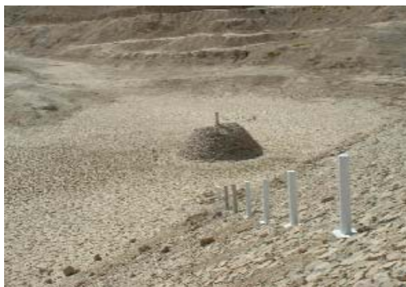
取水塔の周辺に堆積したシルト・粘土（Ghutai Shela DAD） ⑬
