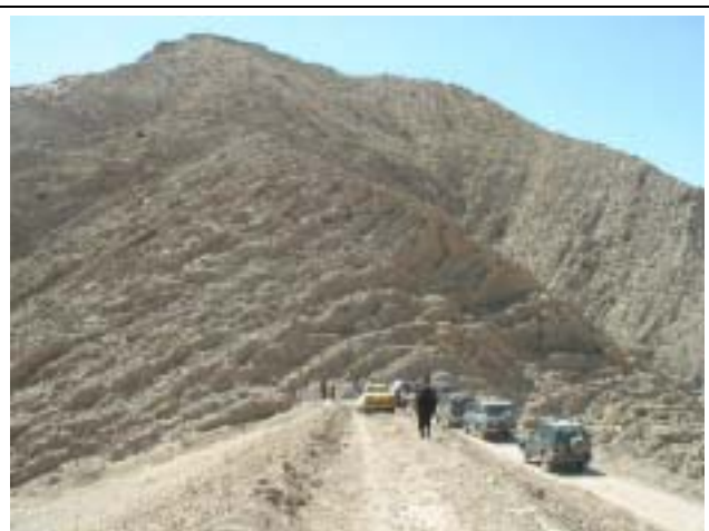
Chinjan DAD の右岸接岸部 風化土掘削の法面掘削はほとんど行われない ④
