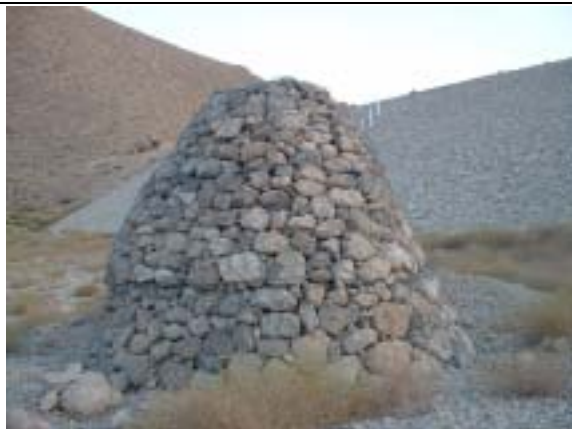
取水塔 石積の中にストレーナー加工 MS パイプが据え付けられている Dara DAD
