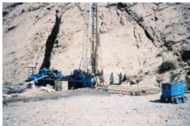
井戸掘り用リグ機材による深井戸（Tube Well）掘削作業 灌漑発電局の監理下 工事請負業者が実施している ③⑨
