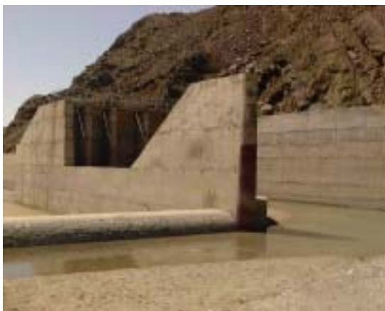
Toiwar FIS 取水堰土砂吐・取水口へのインレ ット部 ㉔
