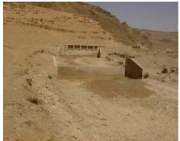
Toiwar FIS 幹線用水路(河川の右岸) 下流側から 上流を望む
