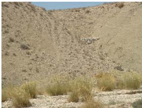
Leaky Dam 上流のチェックダム
