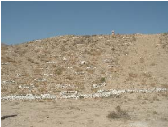
斜面一帯に設けられたマイクロキャッチメント (Leaky Dam) ⑦
