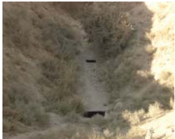
Khusdil Khan Bund Irrigation Scheme 幹線用 水路カルバート部 ㊦
