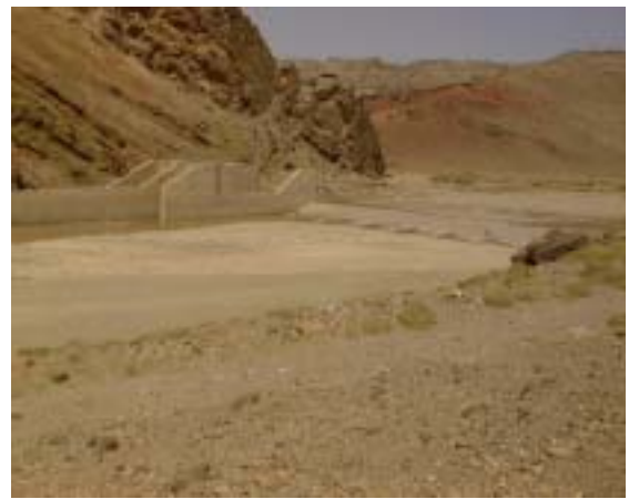
Toiwar FIS 取水堰の全景 ㉔
