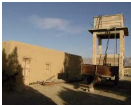
Sariab Farm Mastung の資機材置き場
