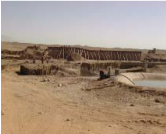
Tora Khula FIS (工事中) 取水工の全景 上流側右岸から ㊤
