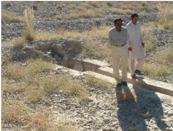
Shagai II DAD の沈砂ピットと導水溝
