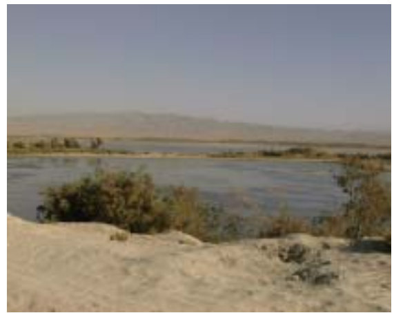
Khusdil Khan Bund Irrigation Scheme 貯水池 全景 ㊦
