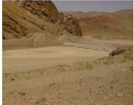
Toiwar Flood Irrigation Scheme (FIS) 取水堰の 全景
