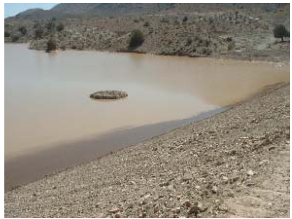
Spera Ragha DAD の取水設備
