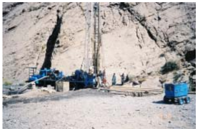
井戸掘り用リグ機材による深井戸（Tube Well）掘 削作業。灌漑・電力局の監理下、工事請負業者が 実施している
