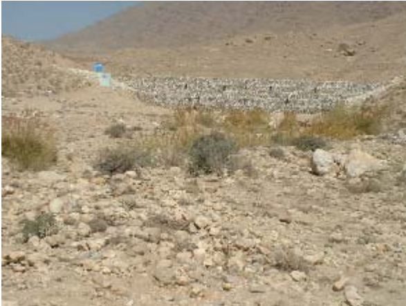
Leaky Dam 遠景
