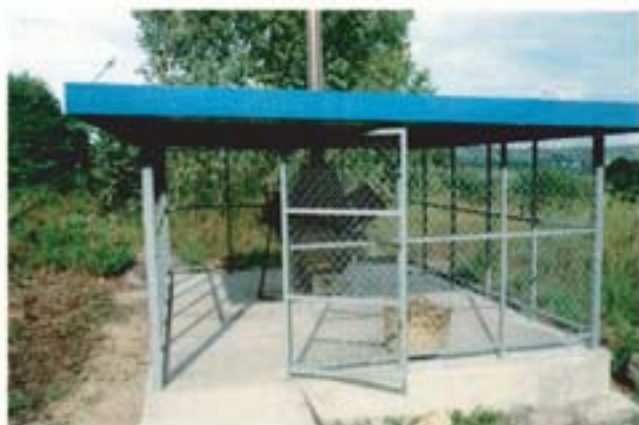
シアヌークビル市の保健区事務所に設置された小型簡易焼却炉。
