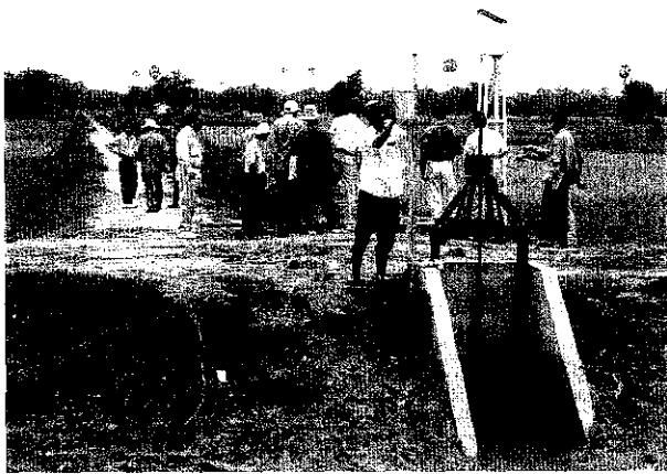
3次水路の取水部(ゲート)手前が幹線水路で奥に向かって3次水路が続いている。
