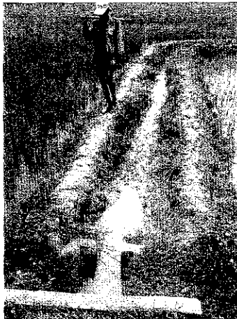
4次水路(3次水路の末端)の様子 日本農業土木総合研究所との連携により整備されている。
