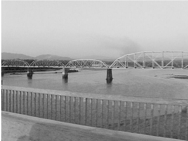
エルサルバドル国レンパ川下流部(国道1号との交差点)
