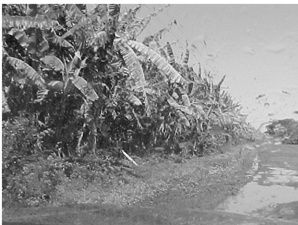
フォンセカ湾へ至る道路(PPPの道路の一部) 路面状態は悪い
