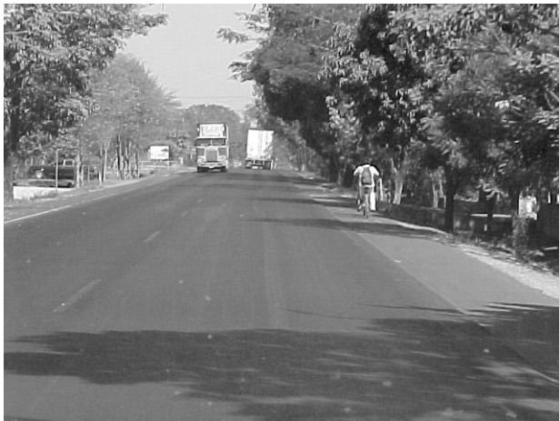
ニカラグア国国道1号レオン付近(PPPの道路の一部)
