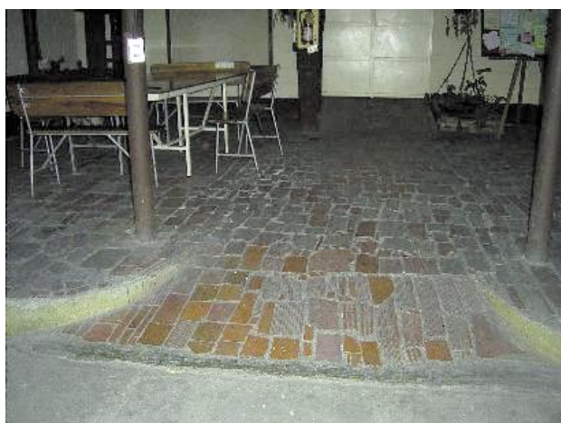
ニカラグア CESTA 建設廃材等のリサイクルによって作られた再生レンガ。
