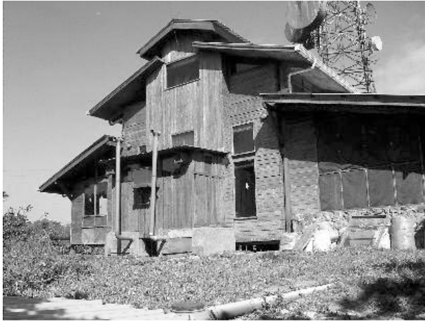
ボルカン・モンパチヨ保護区 公園事務所兼ビジターセンター
