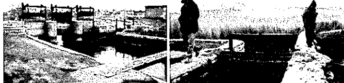
دریچه ورودی کانال سمت چپ این بند در شهر روانسر واقع شده و تنها ۱ کیلومتر با محل سراب فاصله دارد. کانالهای آبیاری از سمت چپ و راست بند منشعب شده و برای طرح های آبیاری و زهکشی امتداد یافته اند. بند انحرافی روانسر (پشت بند)
