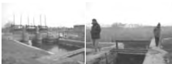
Ravansar取水堰(堰上流側からの情景) 左幹線取水口(同幹線下流側からの情景) 本取水堰は泉から約1.0km下流のRavansar市内にあり、ここでの取水で右幹線水路(水門右岸側に入口が見える)と左幹線水路(右側写真)に分水する。
