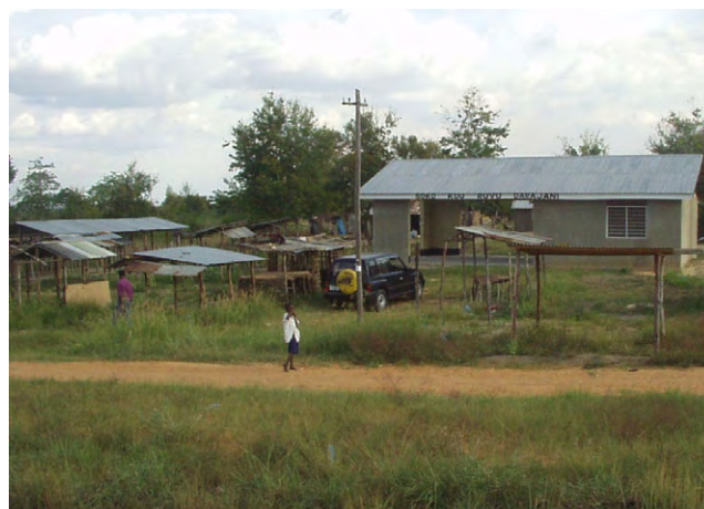
集会所(奥)を中心として農民自身の資金で建設が開始された売店等 (本文 2 - 38 ページ)
