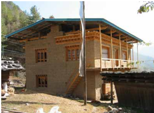
現場 10 : 土壁造の民家 1 (ブロック製造工場傍)
