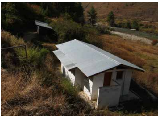
新設された男子トイレ（使用不可） 原因は、学校全体の給水量の不足
