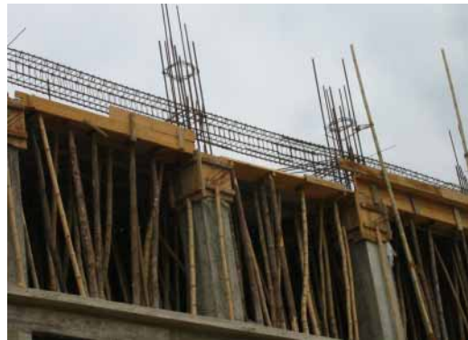
現場 5 : 梁型枠と配筋の様子
