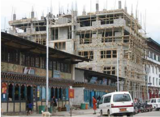
コンクリートブロック壁の建物
