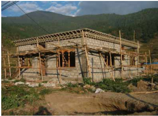
現場 7 : ブロック壁造の建物 (Punakha)
