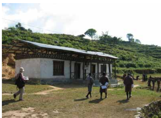
教室棟の外観
