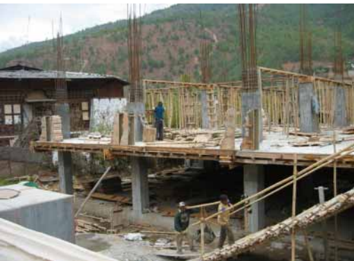
現場 4 : コンクリートの打設風景 1
