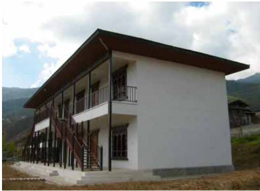
6 教室棟外観 (廊下側)
