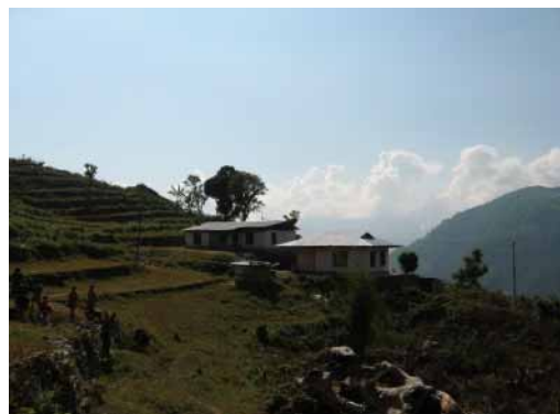
管理棟（左側）とリソースセンター
