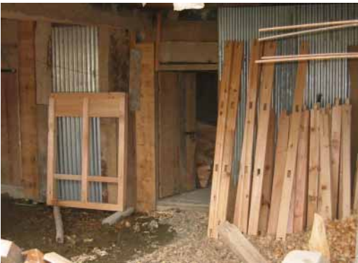
現場内で加工中の木製建具の部品
