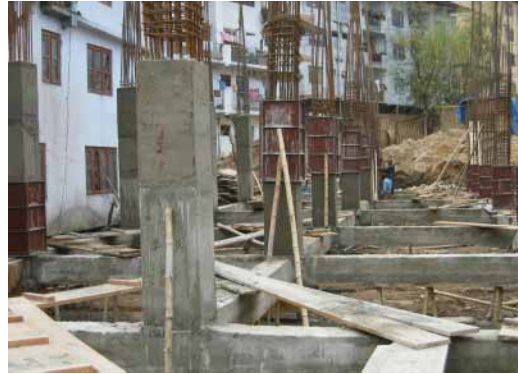
現場 3 : 1階柱の工事 2
