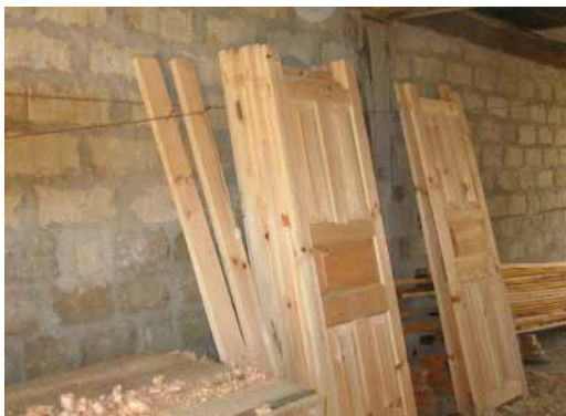
現場 8 : 製作中の木製建具 (3階建ての住宅建設中)
