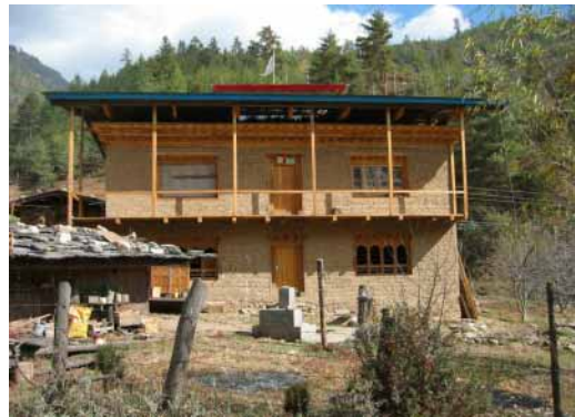
現場 10 : 土壁造の民家 2
