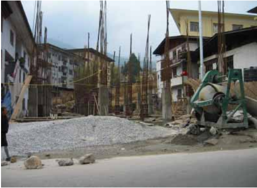
現場 3 : 1階柱の工事 1
