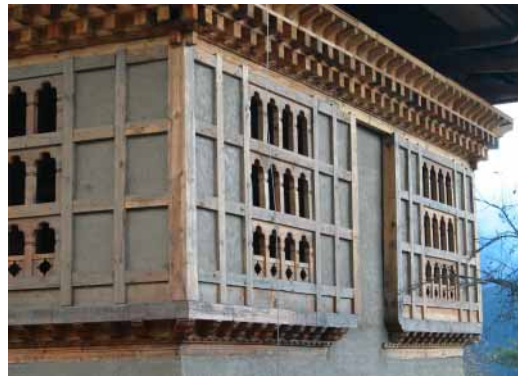
現場 9 : 工事中の民家、木造窓廻り詳細
