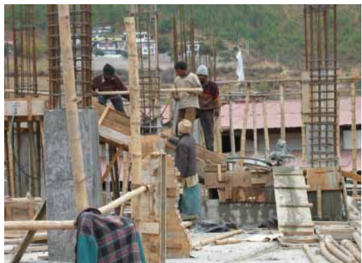
現場 4 : コンクリートの打設風景 2 (階段部の打設)
