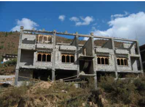
現場 6 : Changjijiの共同住宅 1 (ブロック壁造)
