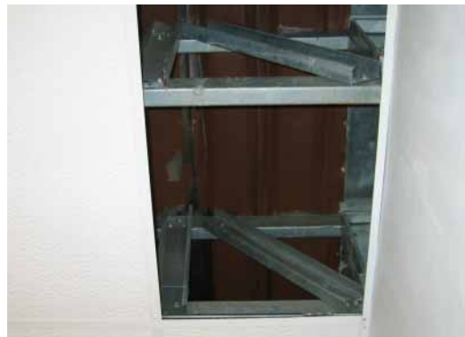
1 階天井裏 (LGS部材による2階床トラス梁)
