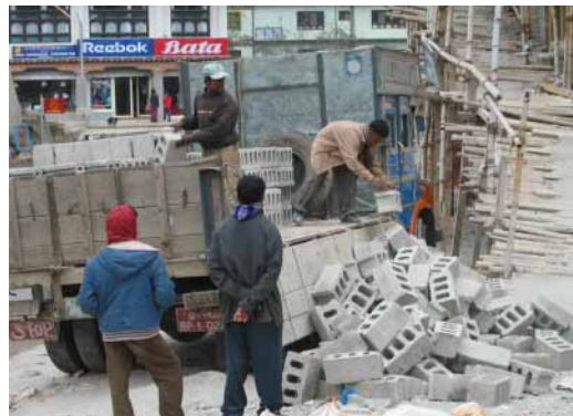
ブロックの荷下ろし風景 (取扱いが荒い)
