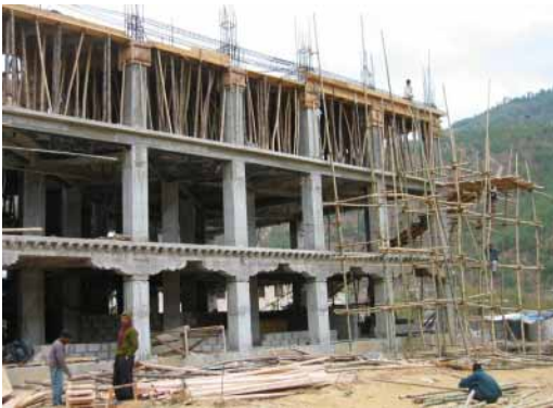
現場 5 : コンクリート躯体と型枠
