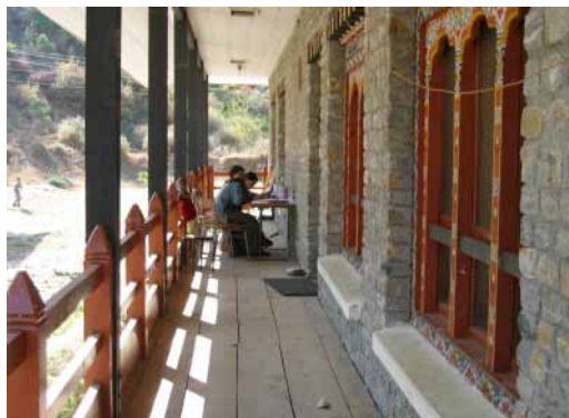
新設の2階図書室前の廊下
