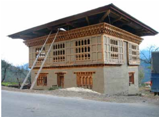
現場 9 : 工事中の民家 (Bitekha)
