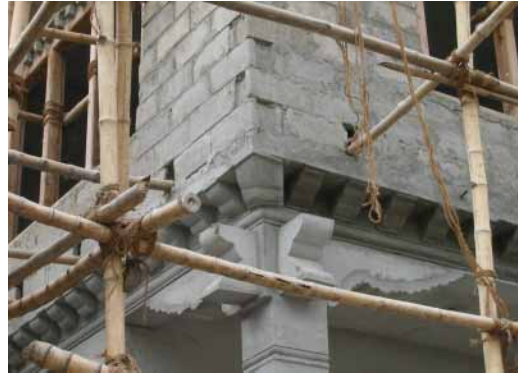
コンクリートの柱頭部装飾部
