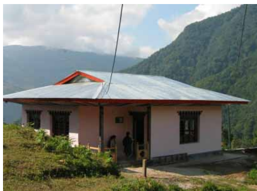
リソースセンター（UNICEFにより建設）
