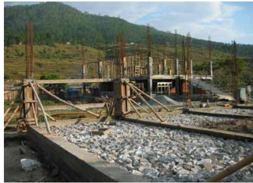
現場 7 : 土間コンクリート下地の様子
