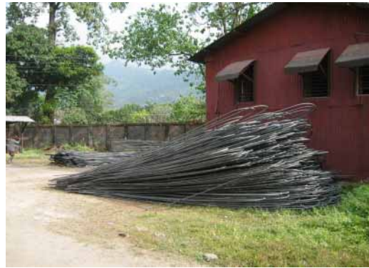
ストックヤードに置かれた太物鉄筋
