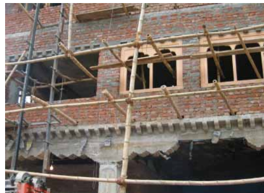
コンクリートの柱頭部装飾と窓周り
