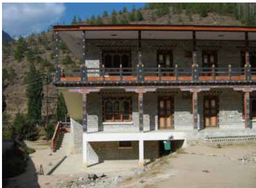
新設の6教室棟（半地下ピットを教材保管室に利用）
