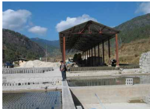
養生用プールから製造ラインを望む
