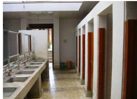
水洗トイレ棟内部
