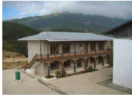
特別教室 / 図書室棟の外観
