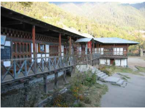
教室棟外廊下
