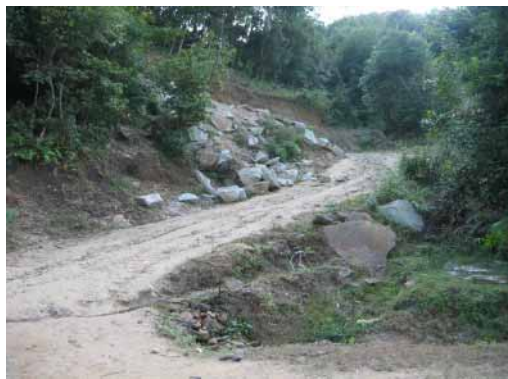
工事途中の道路入口
