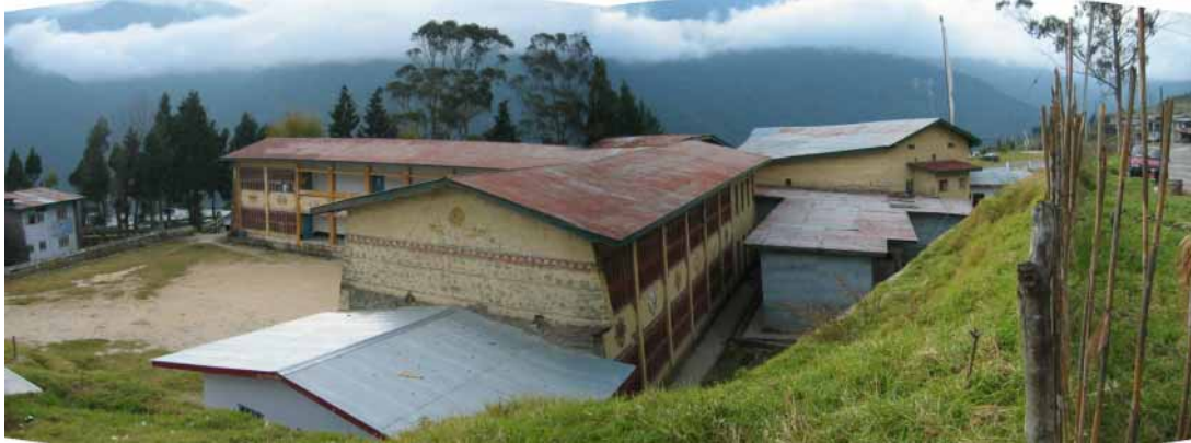
既存校舎全景（右側崖下の平屋建て建物が、取り壊し予定の付属教室棟）
