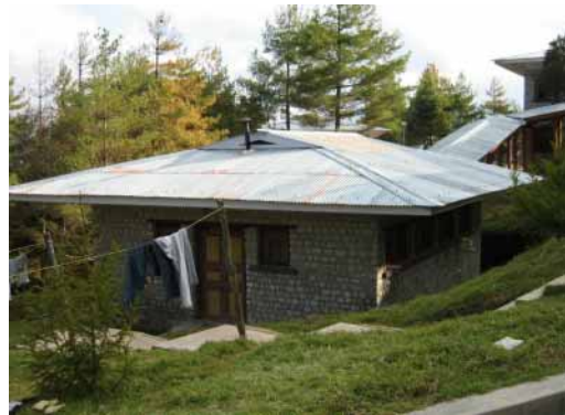
女子寮用水洗トイレ棟と渡り廊下 (右側)
