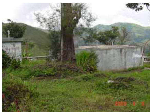
6. エルル配水池
