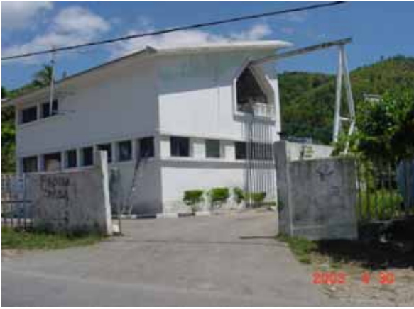
1.ラハネ浄水場
