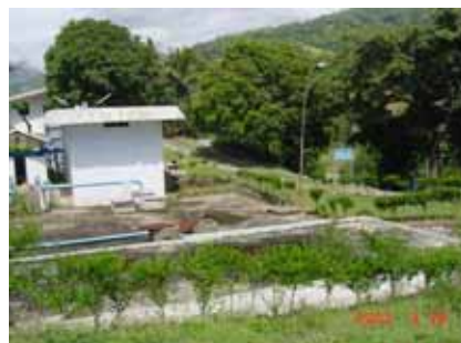
9.下段配水池と滅菌棟
