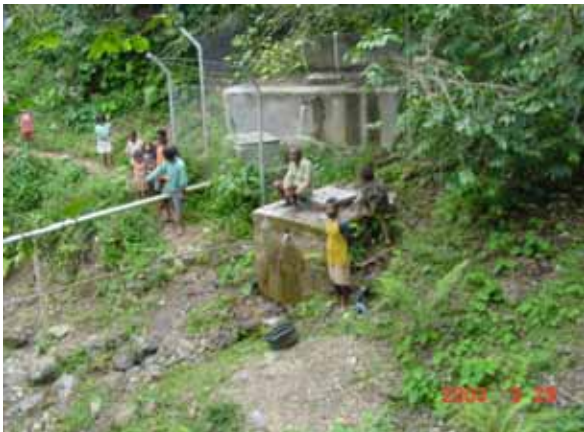
3.エルソイ取水場
