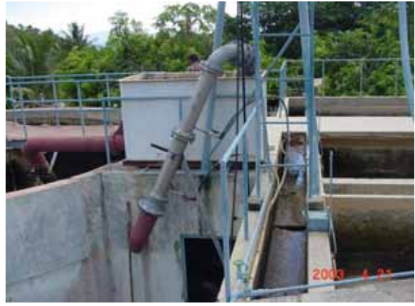
2.仮設着水井 (鋼製)
