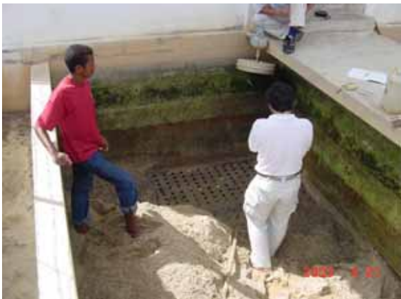
5.急速ろ過池及びノズル
