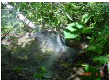
7. 導水管の漏水
