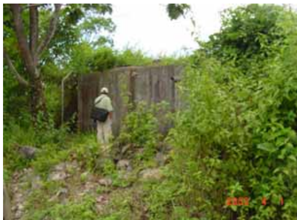
2.メルバチ配水池
