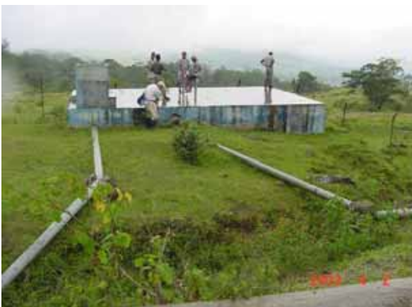
5. ヌグポ浄水場 配水池及び滅菌注入槽
