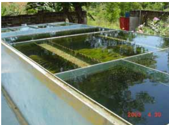
3.フロック形成池と沈澱池 (藻が発生)
