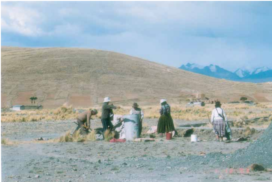
住民参加型で実施されている 灌漑水路の建設状況 (バタージャス市郊外)
