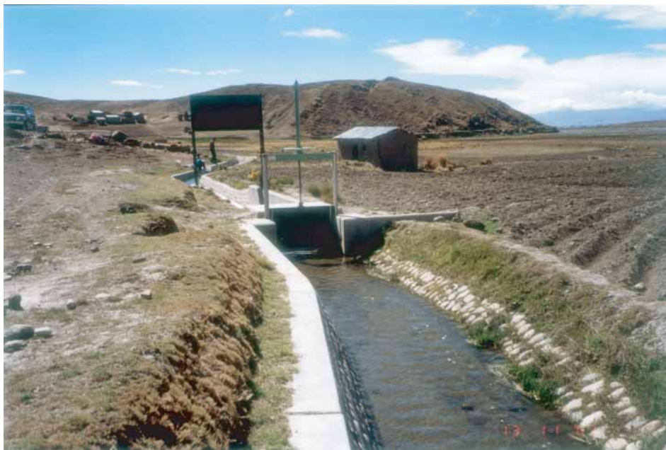
第1期工事で整備された 灌漑水路[SR-12]状況
