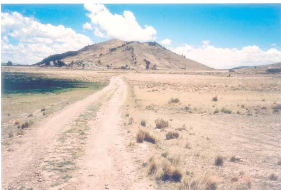
第2期工事で予定されていた 整備前の道路現況
