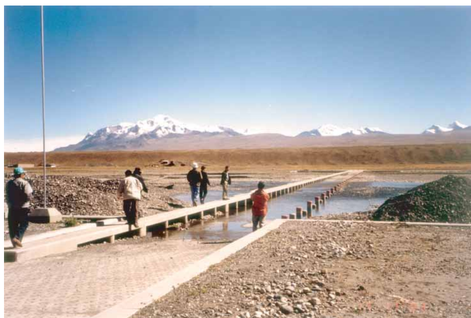
第1期工事で建設された 潜水橋[CP1]
