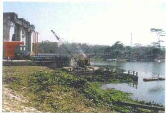
ブランタス流域スングルーダム堆積土砂除去
