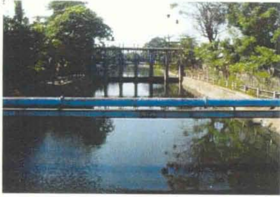
マカッサル市内主排水路
