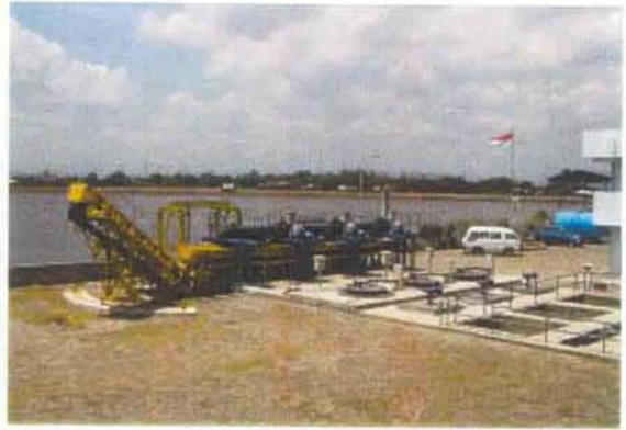
マカッサル市内洪水調節池施設
