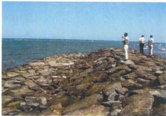
河口の突堤（右岸側）
