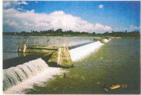
②ラバーダム [1997年国際協力銀行(JBIC)ローンにより建設]
