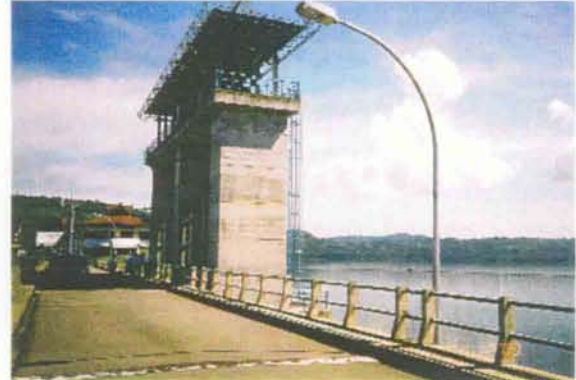
④ビリビリダム (2001年JBICローンにより建設)
