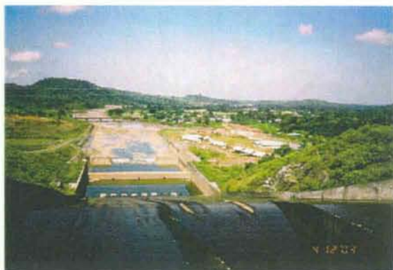
⑤ビリビリダム (放水路)
