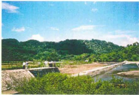
⑦ジェネベラン川上流部の砂防ダム
