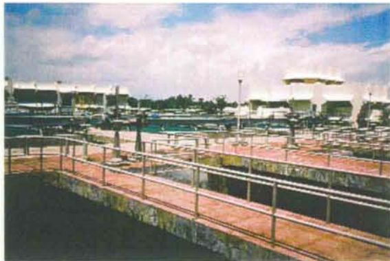
③ソンバオプ浄水場 (2001年JBICローンにて建設)
