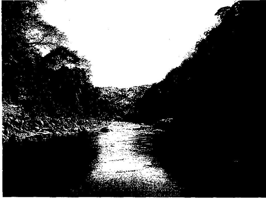
Vista del Sitio de Presa El Chaparral Aguas Arriba
