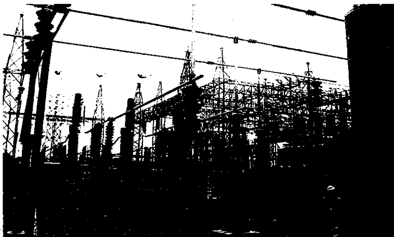
15 de Septiembre Sub Station
