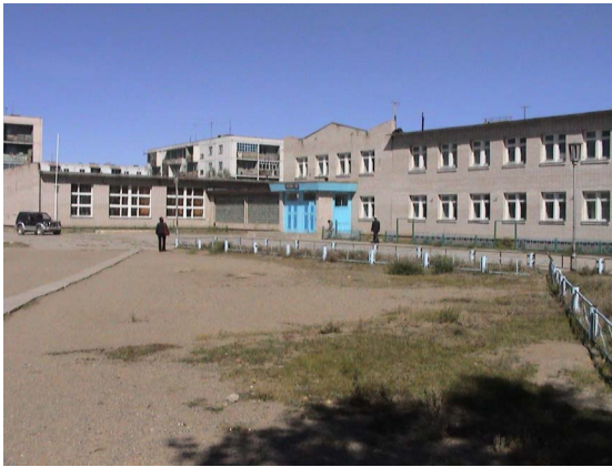
既存第1校舎正面
