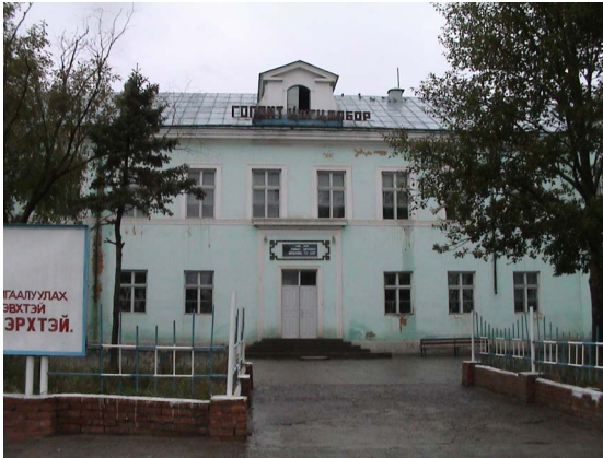
既存第1校舎正面
