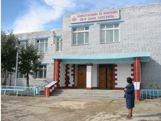
既存校舎正面
