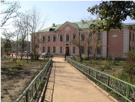
既存校舎正面
