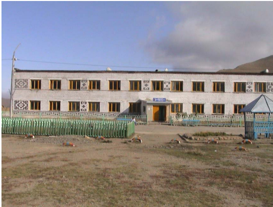
既存校舎正面
