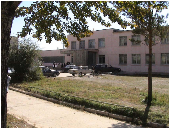
既存校舎正面
