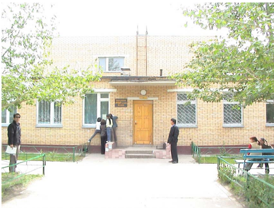
既存第7校舎正面
