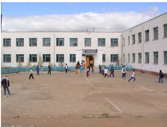
既存校舎正面
