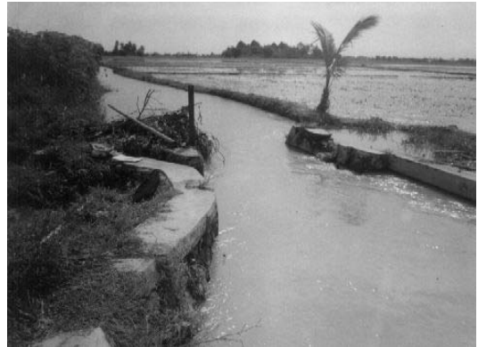
1963年完成。土水路部分。盛土が不十分なため水田と水路の境界が不明確。
