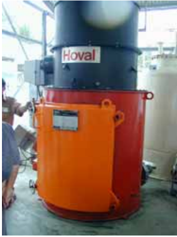
バリアブントオ省立レロイ病院に設置された、医療廃棄物処分用焼却炉。2次燃焼室を持つ高性能炉である。
