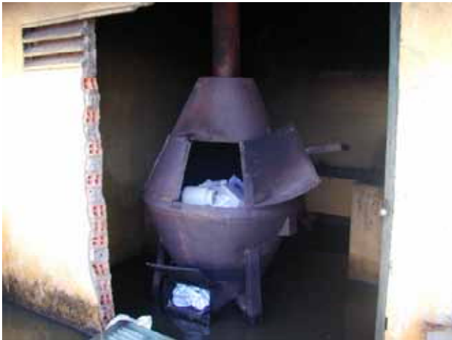
ロンアン省結核病院に置かれている焼却炉。WHOが1997年に試験的に導入したもので、本計画では同型の機種が要請されている。
