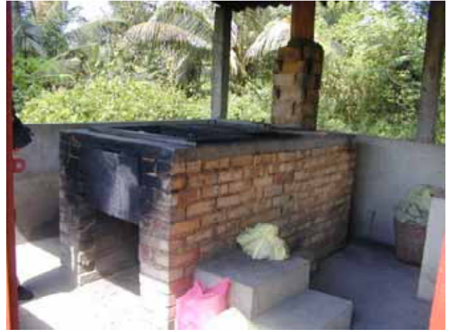
ロンアン省ベンラック県立病院のレンガ製簡易焼却炉。400ドル程度でできるとのこと。県レベルでは、このような焼却炉がしばしば見られる。
