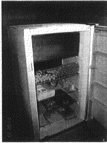
カスンク 県 (Kasungu District) KALULUMA Rural Hospital ワクチン保存用冷蔵庫 (ケボンタイプ)
