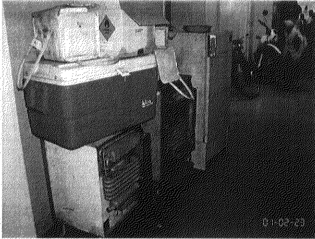
カスガ 県病院 (Kasungu District Hospital) 故障中冷蔵庫
