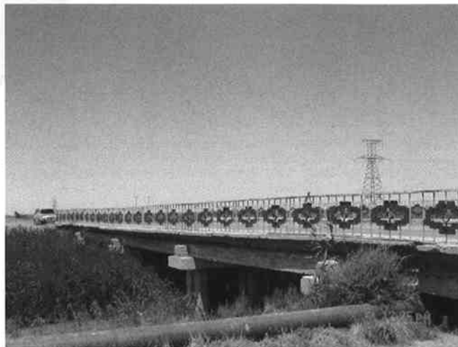
Км 302 Мост 5 x 9м секции.
