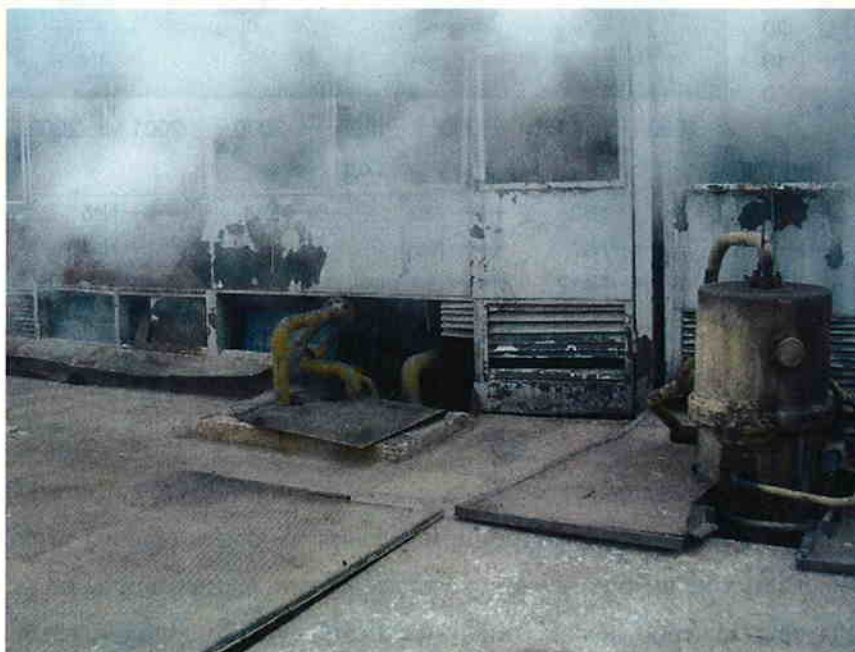
Фото 5.1-13 Утечка пара из турбины
