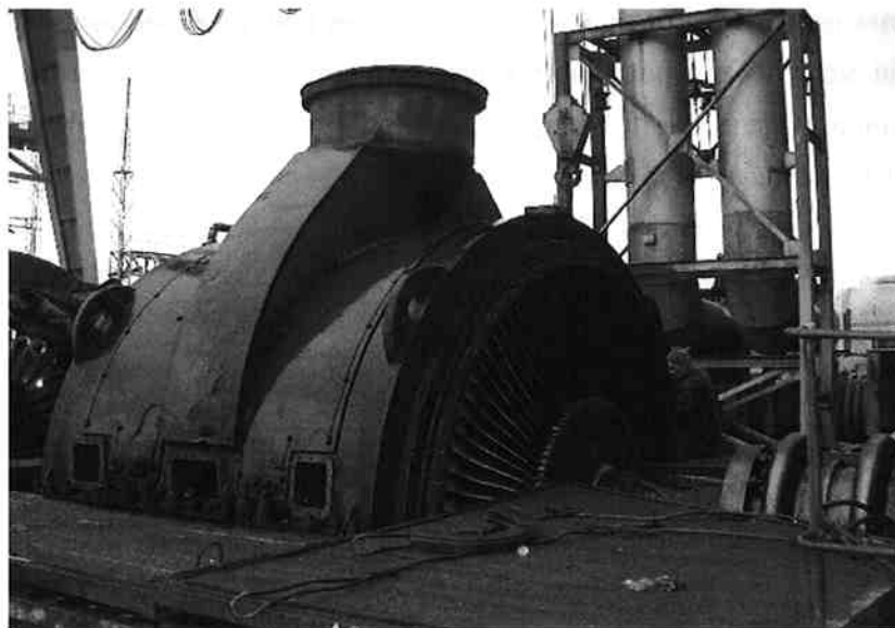
Фото 5.1-5 Проведение обслуживания корпуса турбины на открытом воздухе
