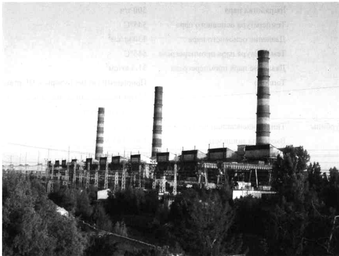
Фото 5.1-1 Существующая Ташкентская теплоэлектростанция
