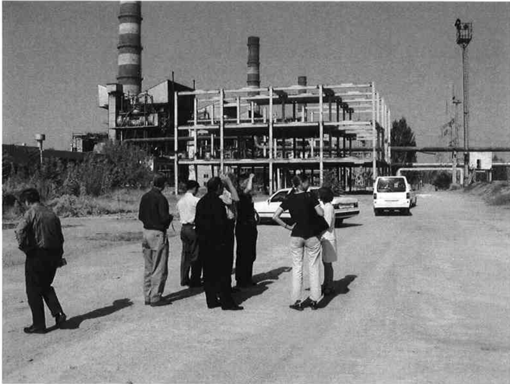
Предполагаемый участок под строительство нового энергоблока ПГУ
