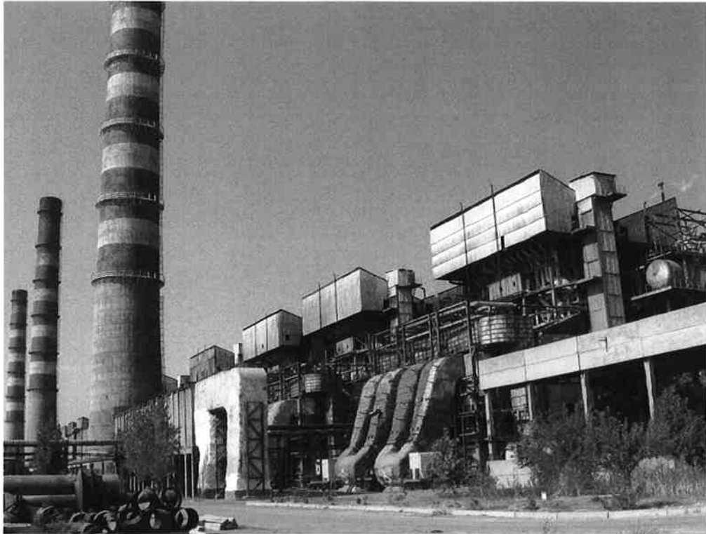
Существующее оборудование котла (блоки №11 и №12 с правой стороны)
