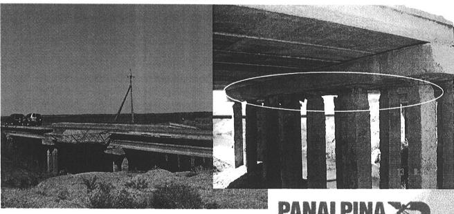
Km65.0鉄道踏み切り。頭上5.4mに電線。Km70.03x6mの橋。Km75.03x9mの橋。はりがいたんでいるため修繕必要。Km84.03x9mの橋。橋げたが道の右側が痛んでいるため、左によること。Km89.03x9mの橋。Km90.03x9mの橋。
