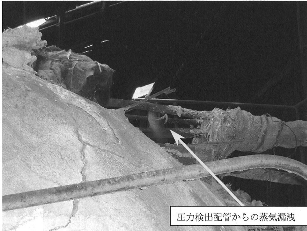
Picture 5.1-15 6号ボイラードラム上部
