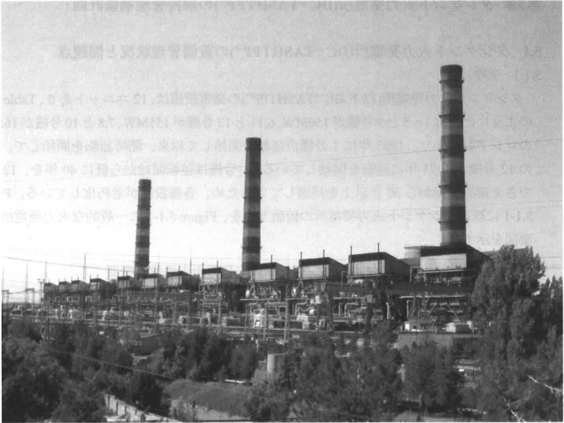
Picture 5.1-1 既設タシケント火力発電所俯瞰
