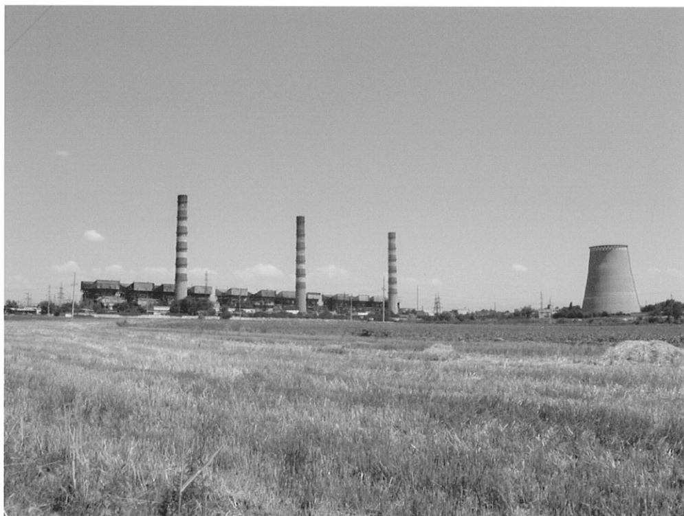
タシケント火力発電所全景
