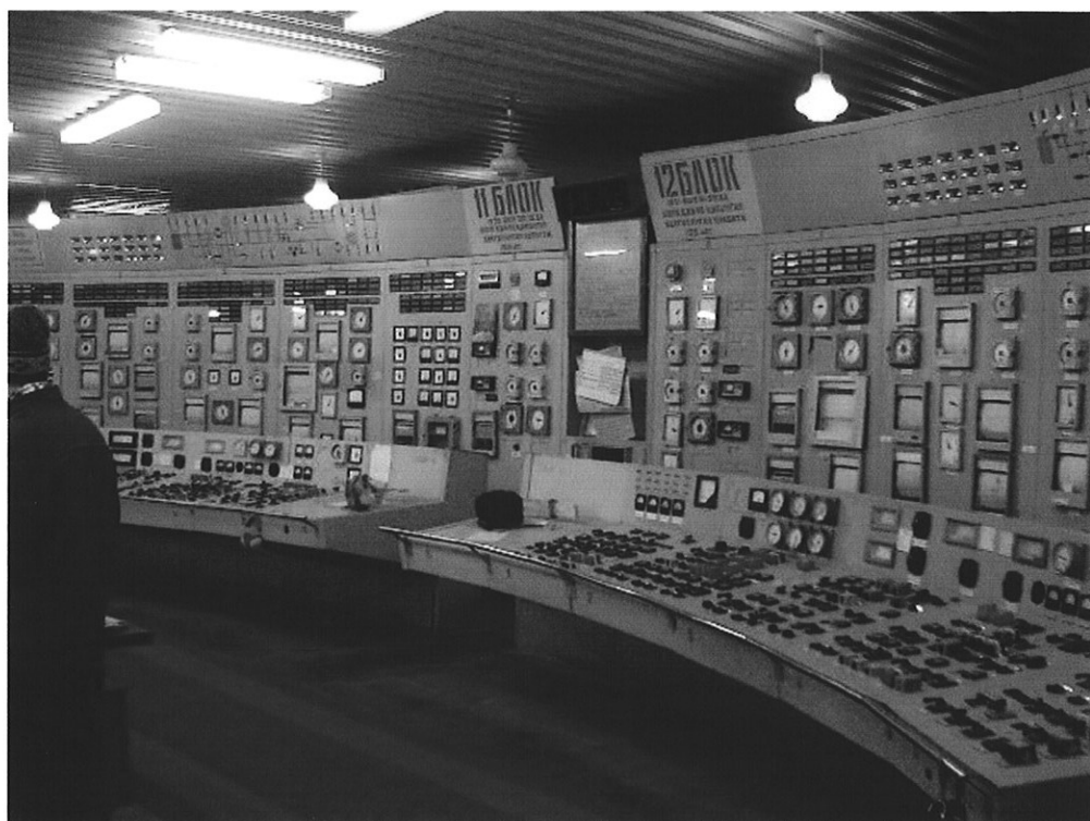
既設中央操作室
