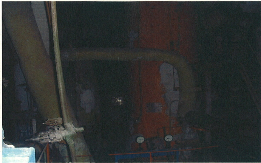
Picture 5.1-5 タービン補機建屋内の状況
