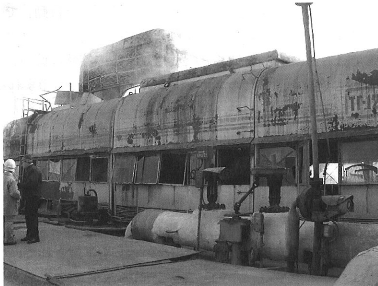
Picture 5.1-2 タービンのカバー全景
