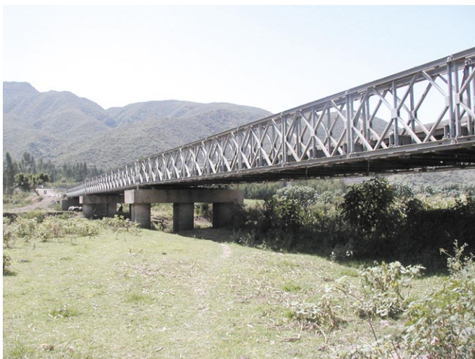
洪水対策としてワールド・ビジョンが支援した橋梁
