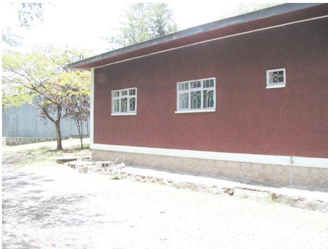
プロジェクト候補サイトの事務所
