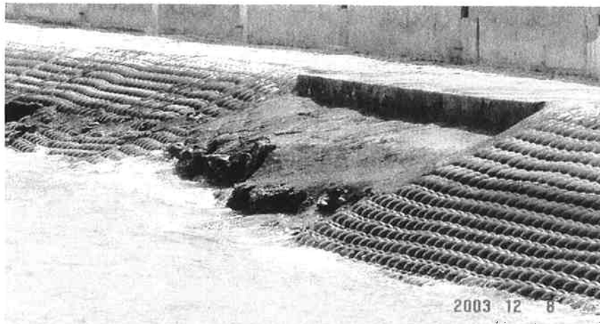
写真 4 天端は鉄筋コンクリートで補修。法面は袋セメントで補修
