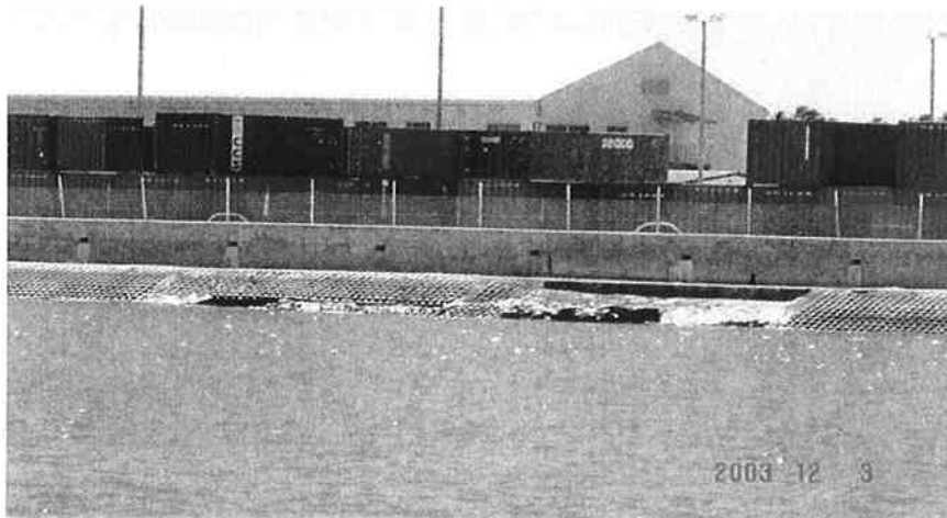
写真 5 小規模 30-50cm 滑落した法面の補修、ホールは大規模崩落部分
