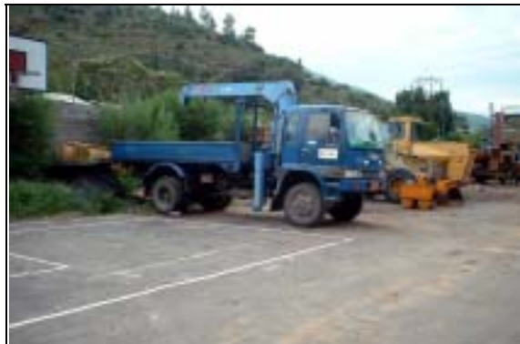
24. ヘソタンカ地域修理工場にあるトラッククレーン
